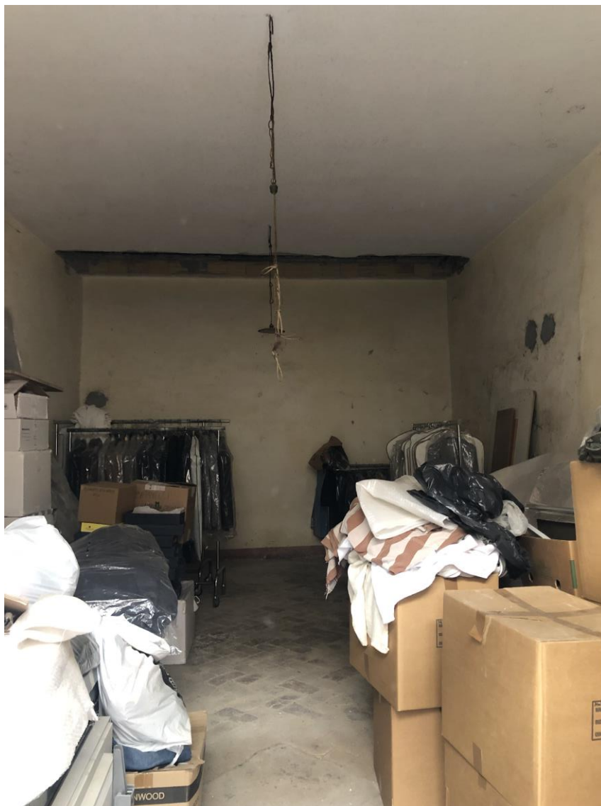
FOTO N. 04, 05 – Viste del vano soggiorno (ex cantina) al piano terra
