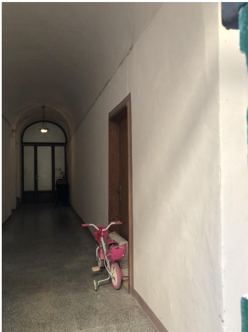
FOTO N. 03 – Vista dell'ingresso comune al civico 27
