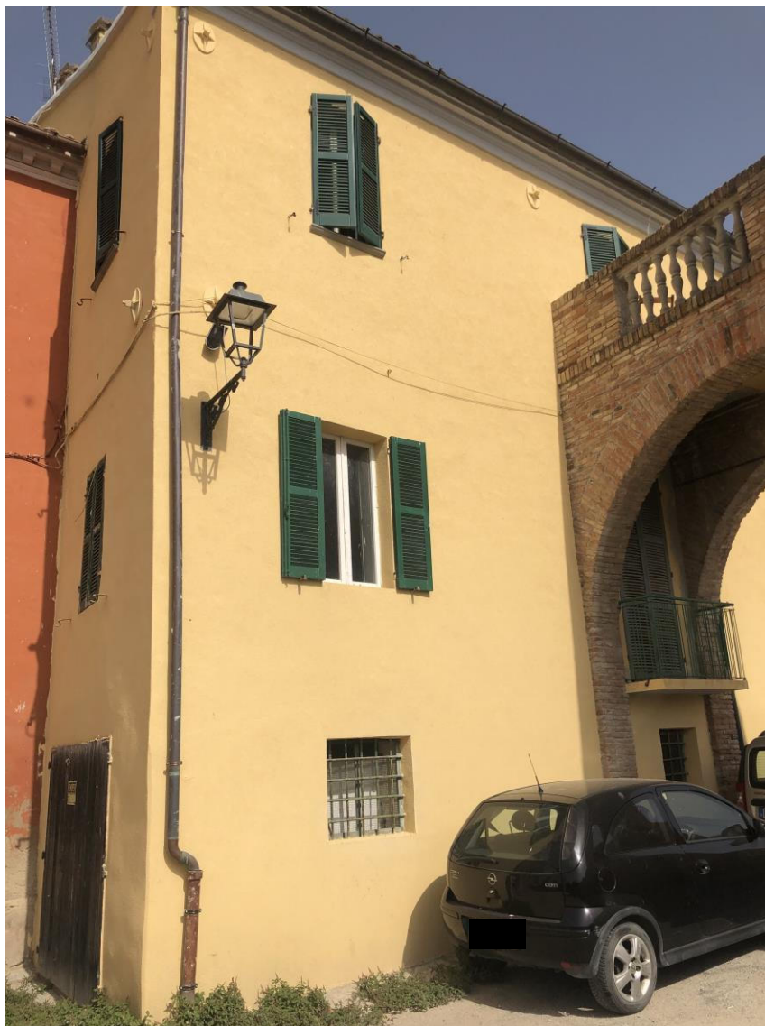
FOTO N. 02 – vista del retro del fabbricato e del fianco destro (ingresso al garage)
