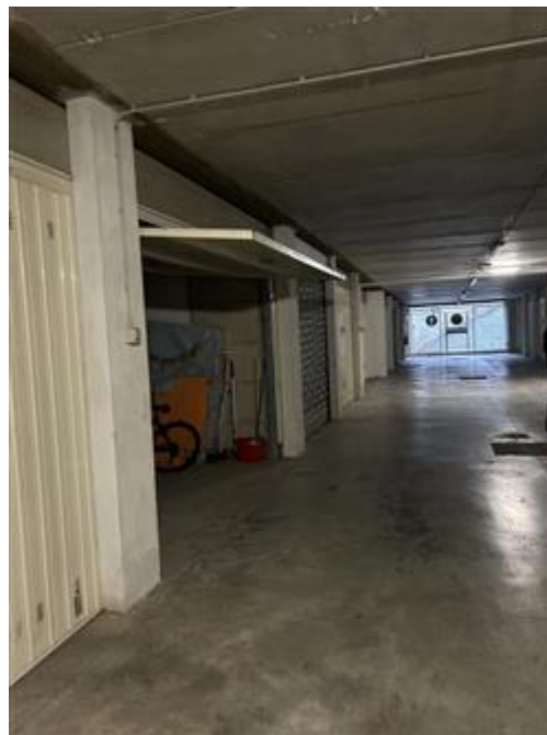
Corsello condominiale di accesso ai garage al piano S1
