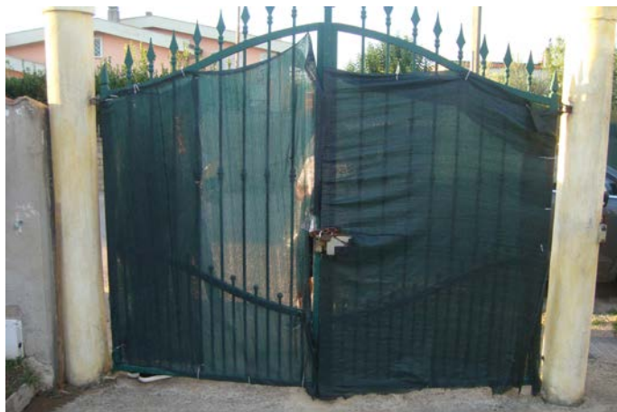
Foto 06 – Vista cancello di entrata lato Nord
