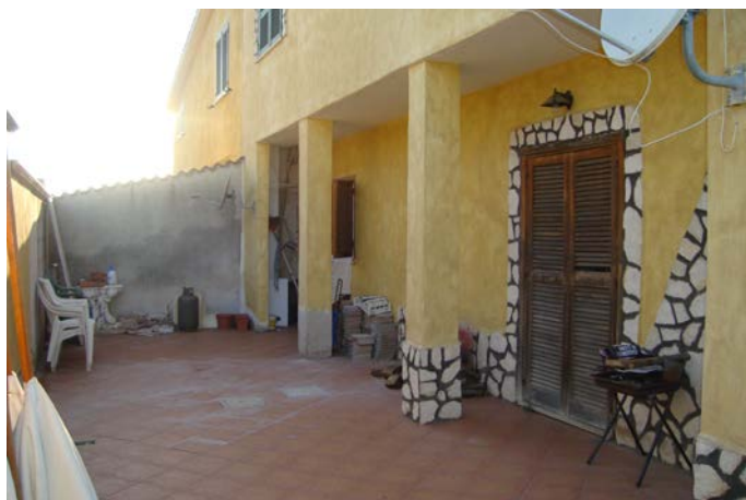
Foto 03 – Vista esterna fabbricato lato Sud
