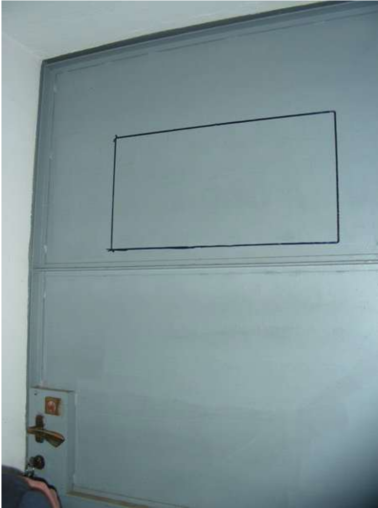
Foto n.45: Porta di accesso al Lastrico Solare
