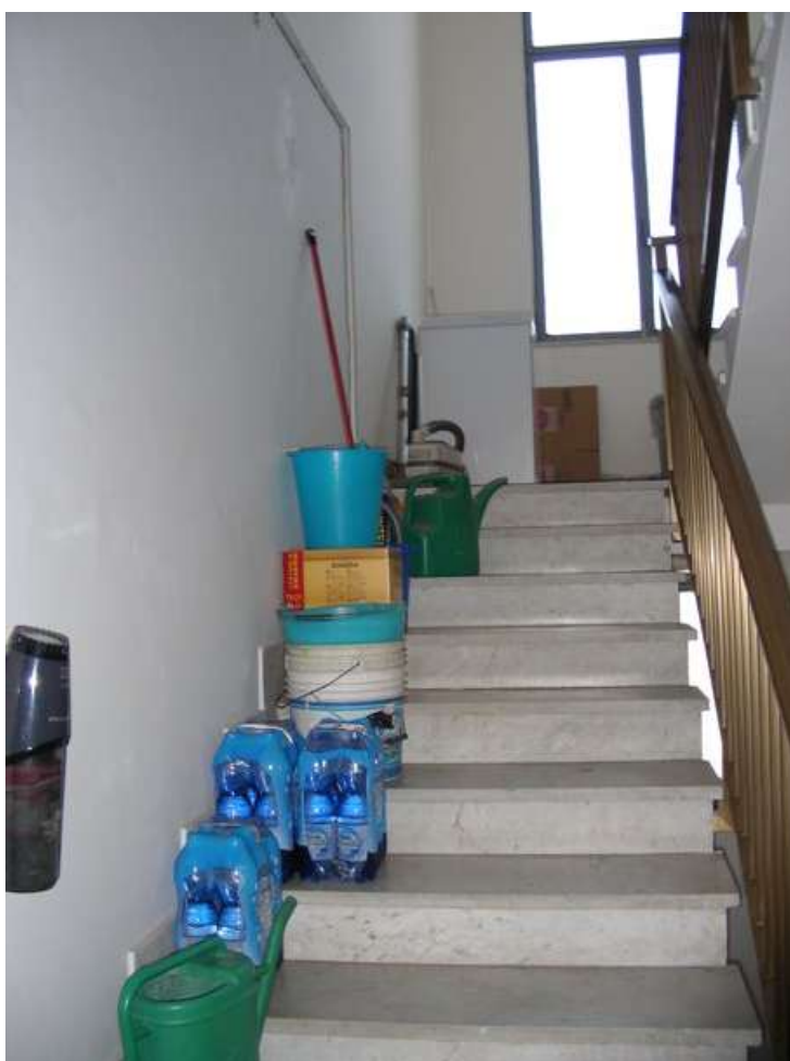
Foto n.44: Scala per accesso al Lastrico Solare
