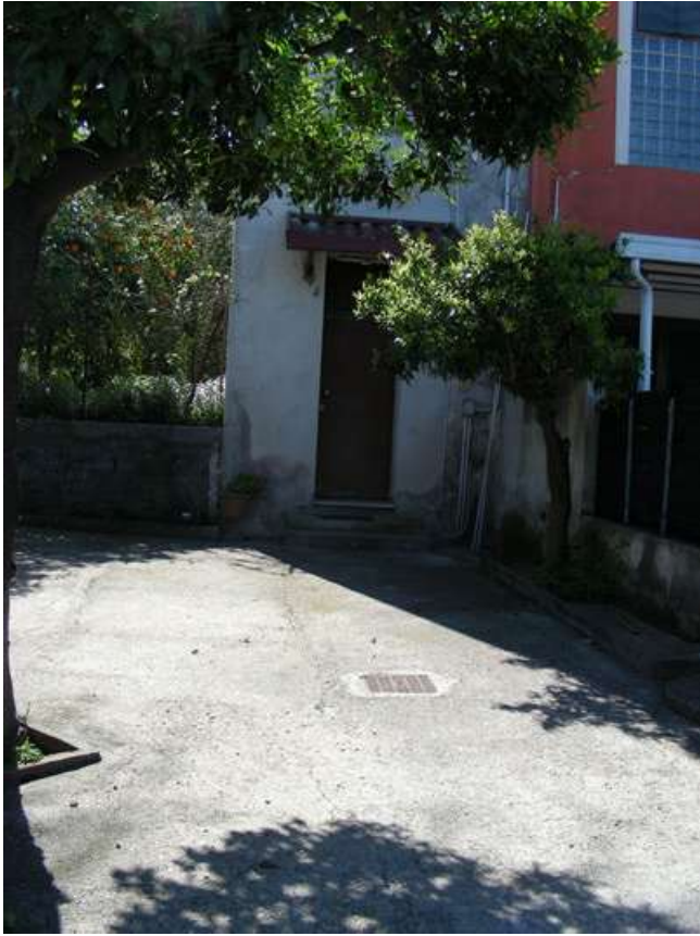
Foto n.9: Porta d'ingresso al vano scala
