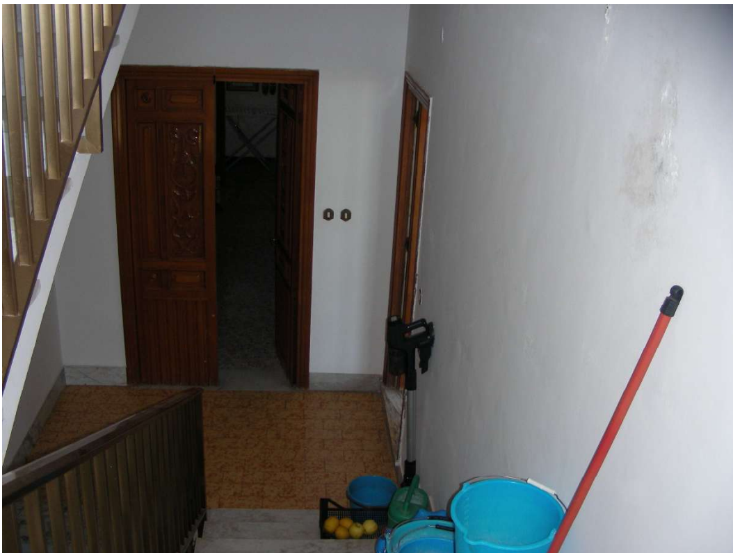
Foto n.14: Porta d'ingresso all'appartamento, sulla dx porta d'accesso al terrazzo
