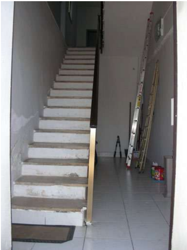
Foto n.12: Vano scala piano seminterrato-terra
