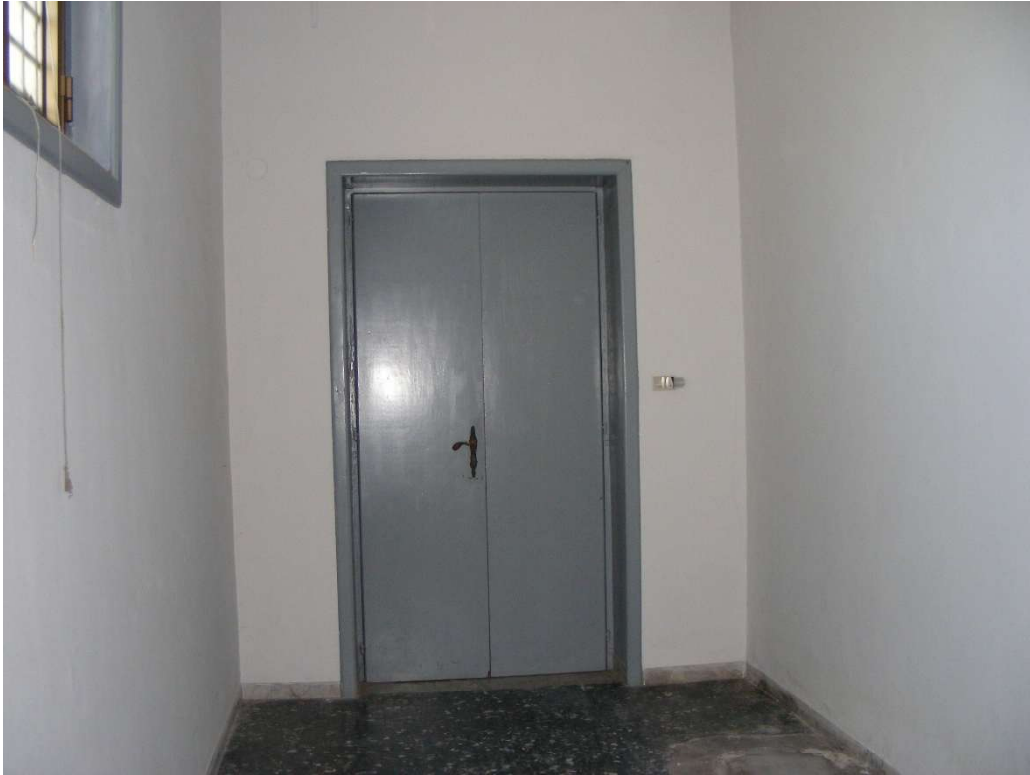
Foto n.13: Porta del Ripostiglio posto sul primo pianerottolo.
