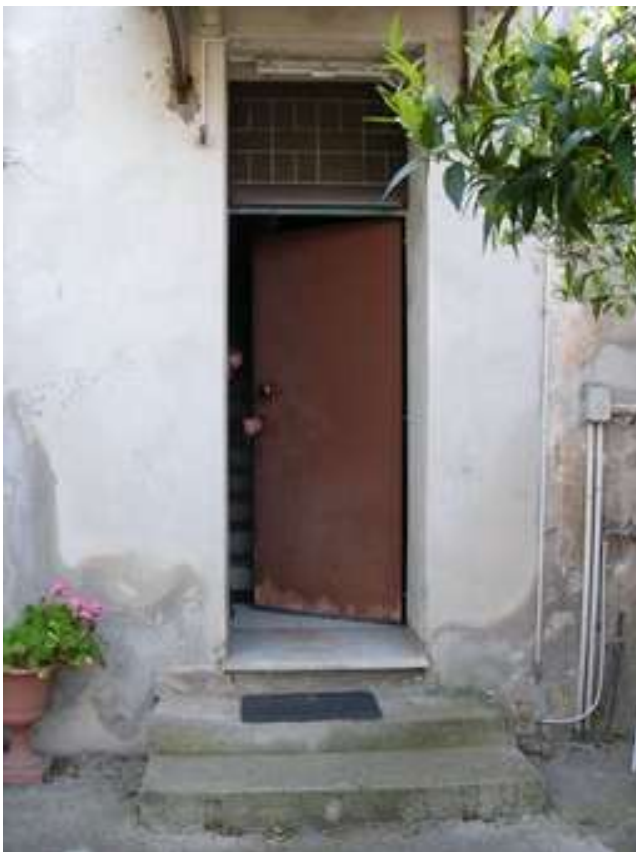
Foto n.10: Porta d'ingresso al vano scala
