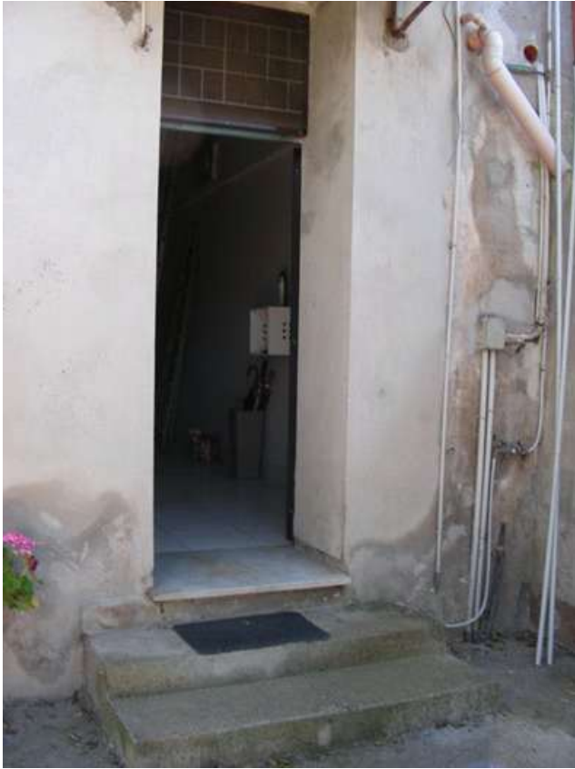
Foto n.11: ingresso al vano scala
