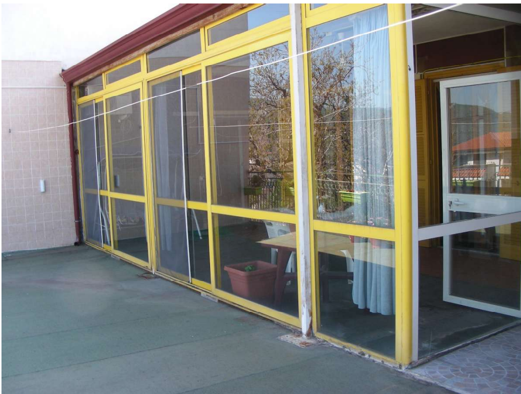
Foto n.18: Verandata sul terrazzo a livello
