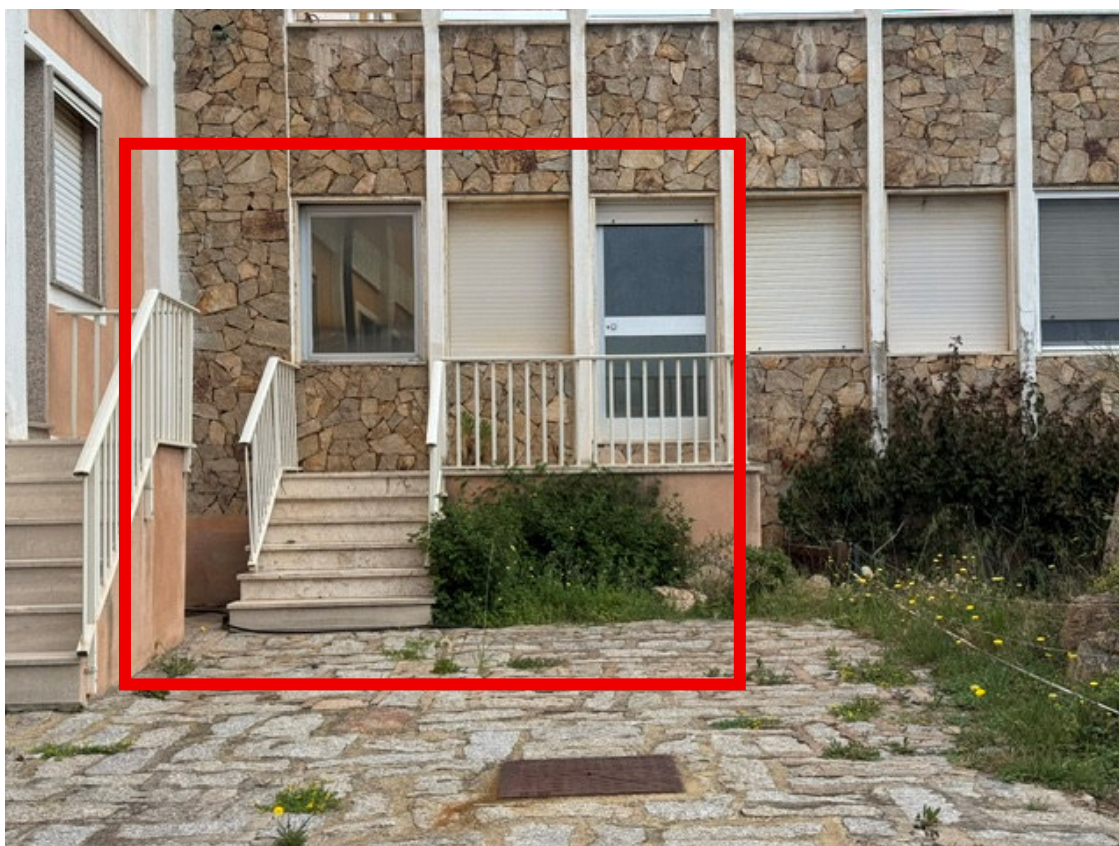
VISTA PPROSPETTO LATO MARE CON INGRESSO SECONDARIO ALL'IMMOBILE INTERNO N. 16
