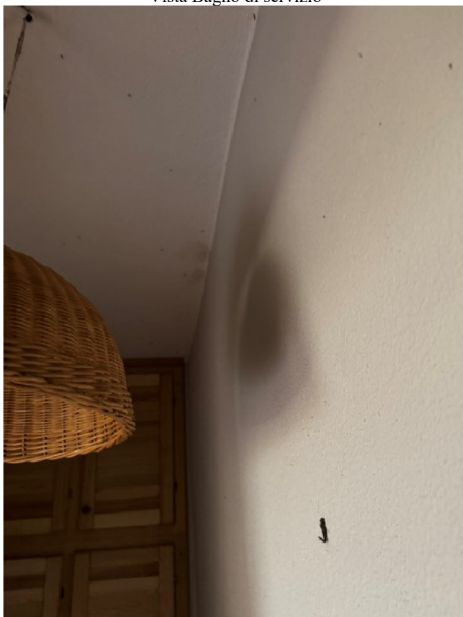
Vista murature disimpegno
