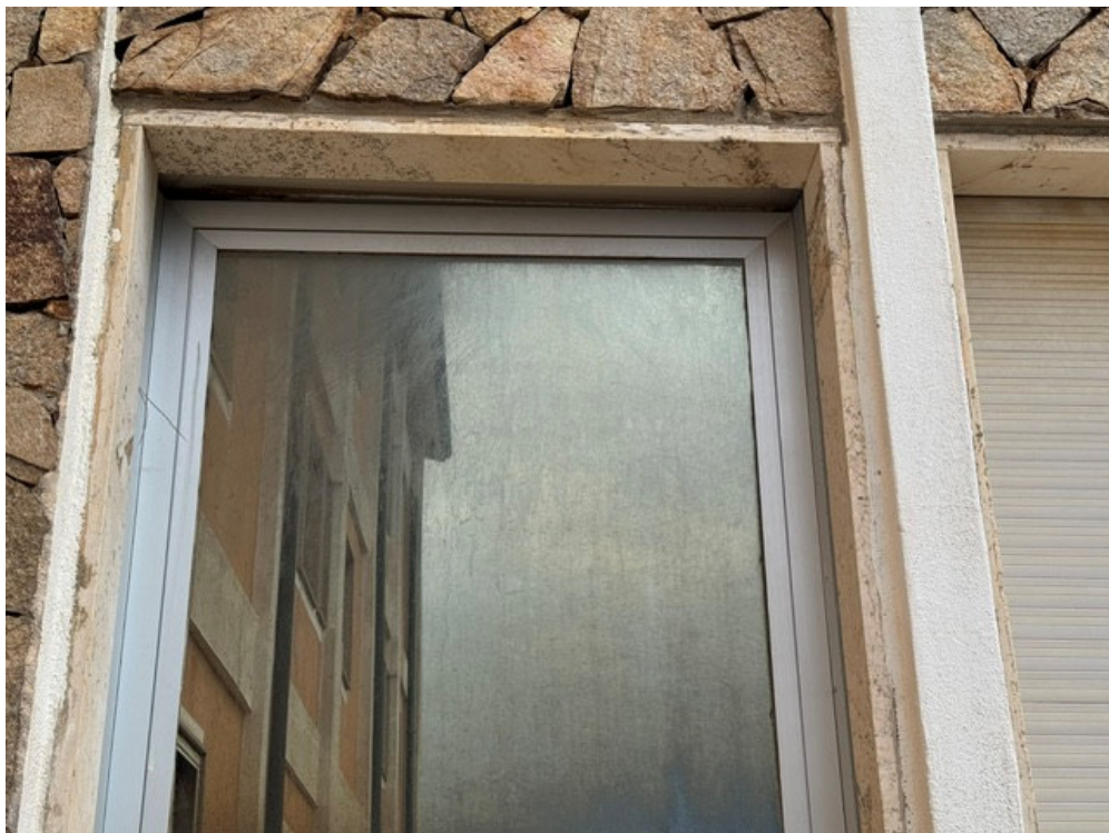
Vista finestra lato corte condominiale
