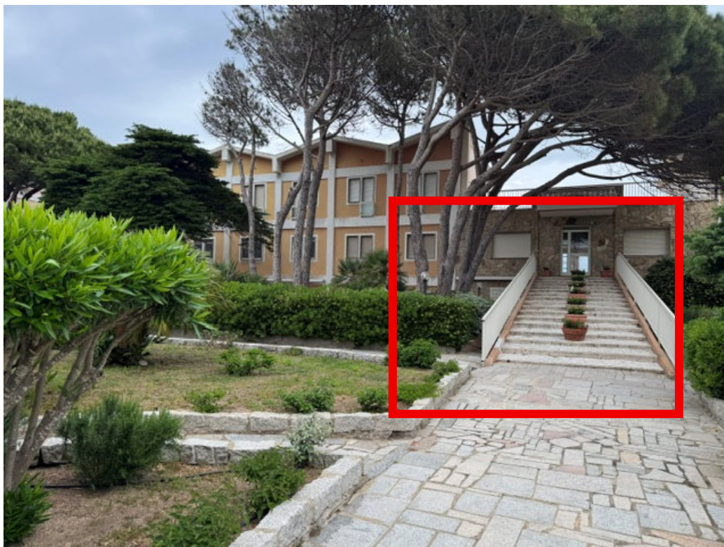
SCATTO DALLA VIA ..... VISTA PROSPETTO PRINCIPALE CON IDENTIFICAZIONE DELL'INGRESSO AL COMPLESSO RESIDEN ZIALE OVE E' UBICATO L'IMMOBILE OGGETTO DI PERIZIA
