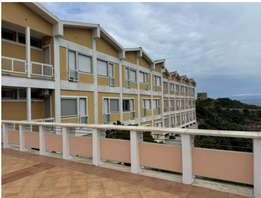
SCATTO DALLA TERRAZZA FRONTE MARE VISTA PROSPETTO PRINCIPALE
