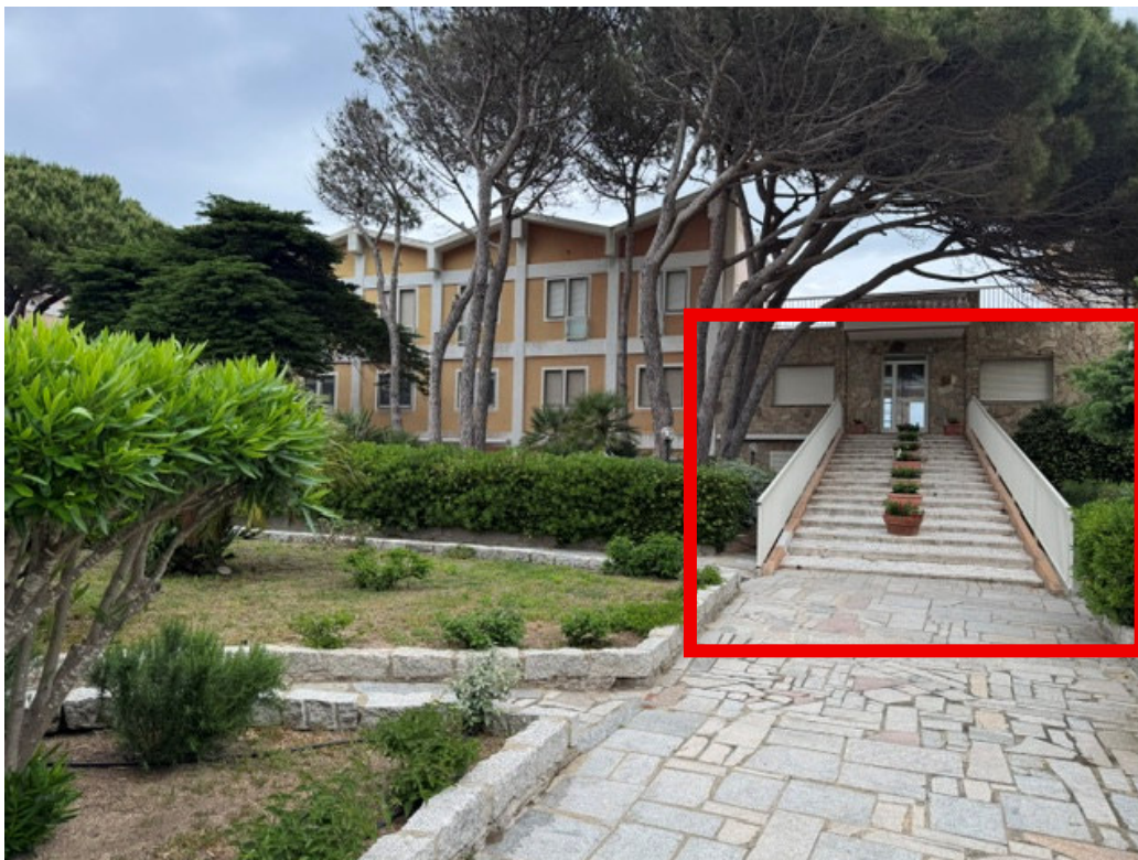
SCATTO DALLA VIA ARNO SANTA TERESA GALLURA VISTA PROSPETTO PRINCIPALE CON IDENTIFICAZIONE DELL'INGRESSO AL COMPLESSO RESIDEN ZIALE OVE E' UBICATO L'IMMOBILE OGGETTO DI PERIZIA
