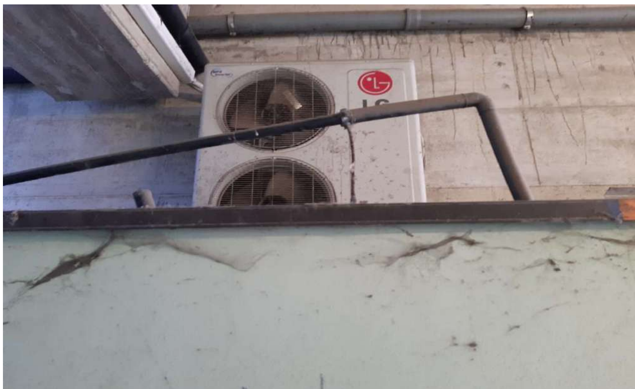
Foto 20 Particolare pompa di calore cavedio esterno
