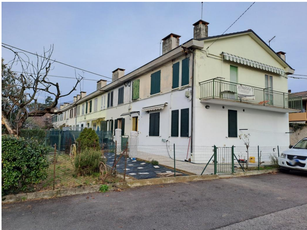
2. Vista generale da Sud
