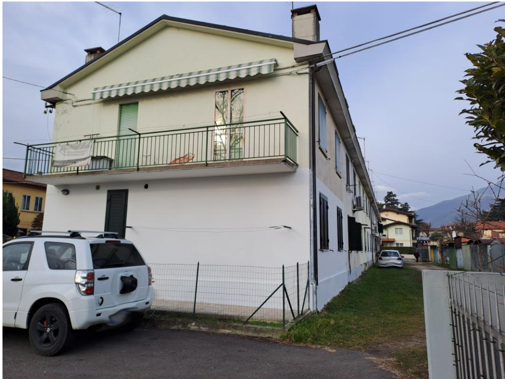
3. Vista generale da-Est
