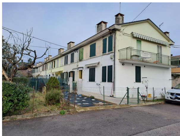
Vista generale da Sud
