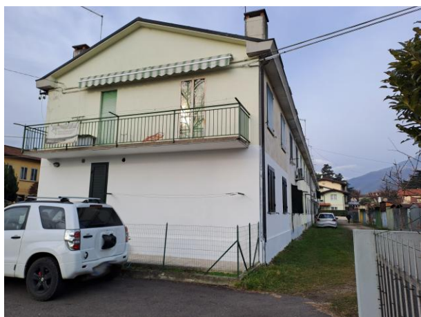
Vista generale da-Est
