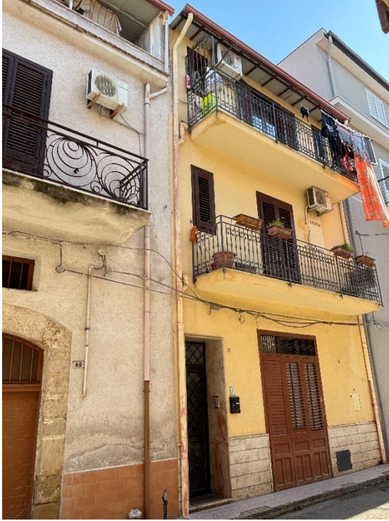
Foto n. 1 – Prospetto su via Di Stefano
