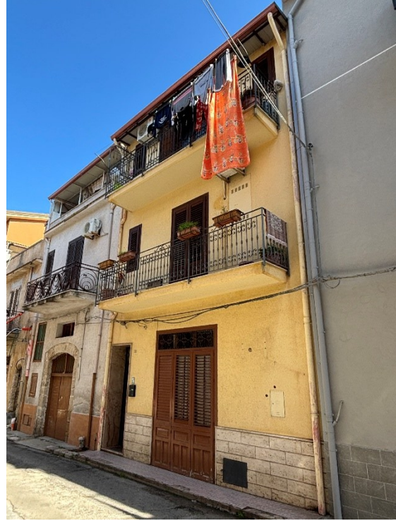
Foto n. 2 – Prospetto su via Di Stefano
