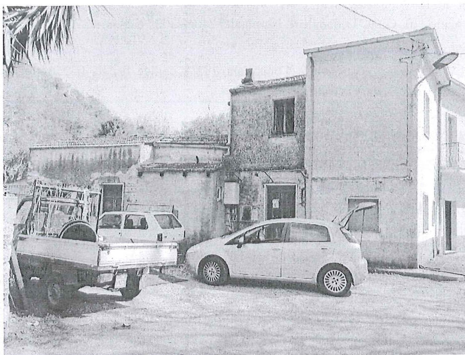
VISTA 1 DEL FABBRICATO
