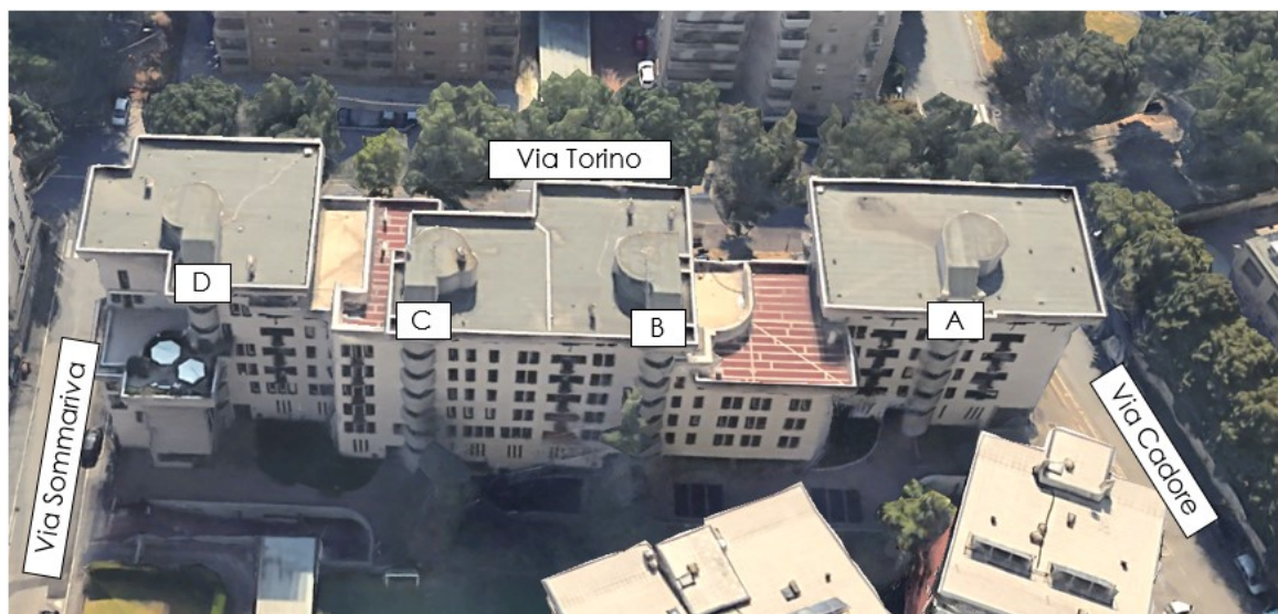
Stralcio vista da google earth – vista da nord-ovest
