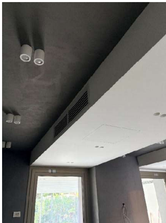
Foto 14 e 15 - Soggiorno e canali di ventilazione a controsoffitto
