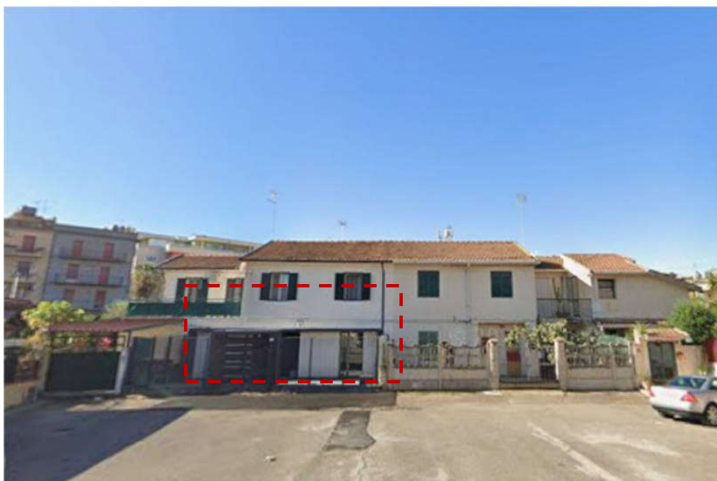
Foto 4 – Prospetto principale su via Bari – Tratteggiato in rosso l'immobile in oggetto
