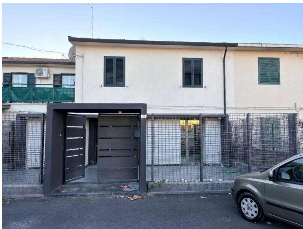
Foto 5 – Prospetto principale su via Bari – Cancelli di ingresso
