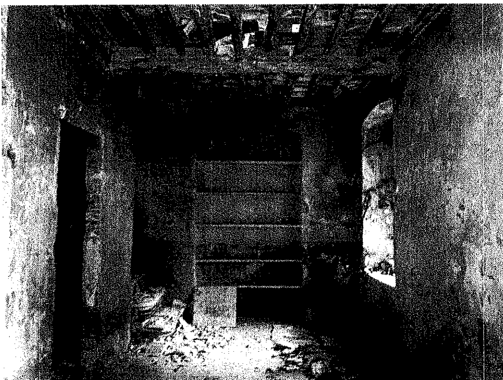
Foto 6 – Vista interna alloggio custode
