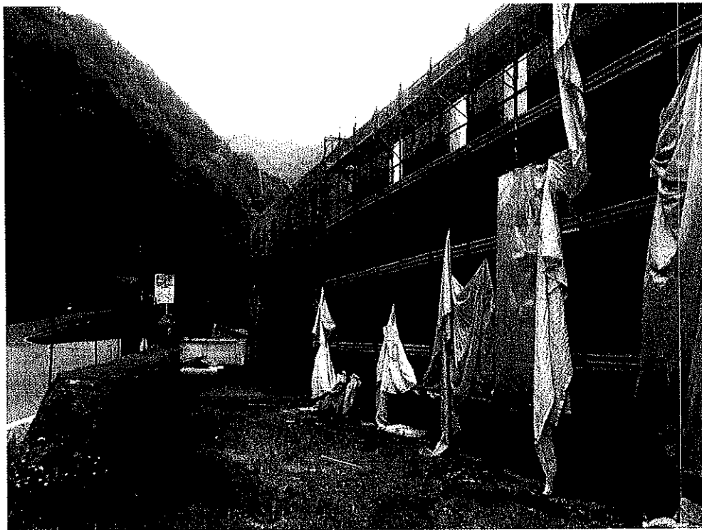
Foto 1 – Vista esterna corpo principale
