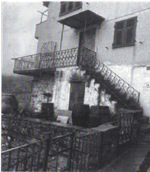
fabbricato di via alla marina
