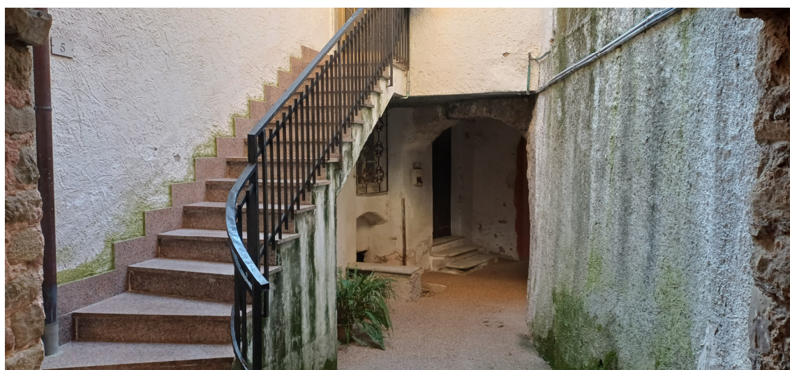
Foto n° 3, 4 e 5 – Prospetto principale su via Pizzarra
