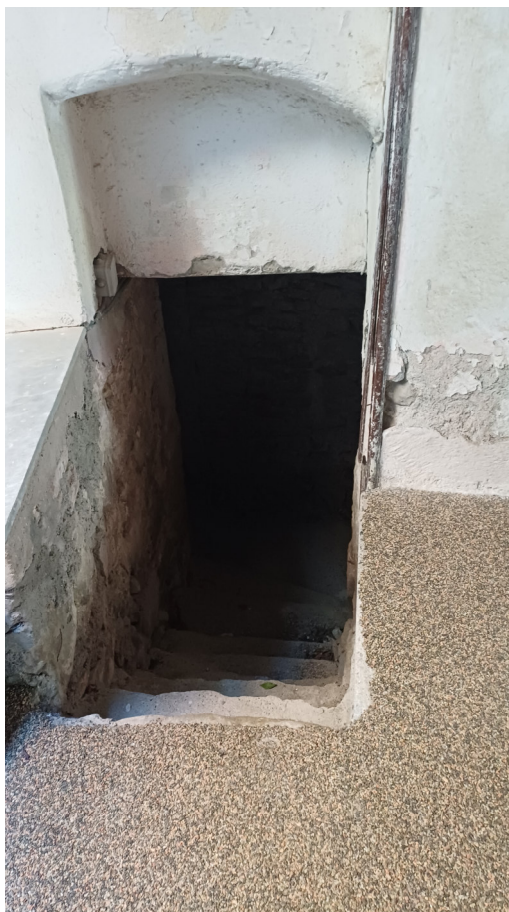
Foto n° 6 – Particolare dell'accesso alla cantina seminterrata
