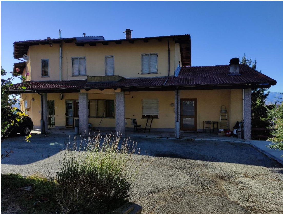
Vista facciata est verso Via Provinciale
