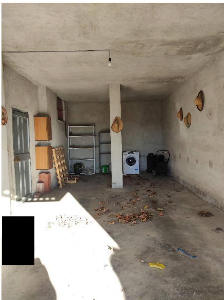
Vista interno autorimessa
