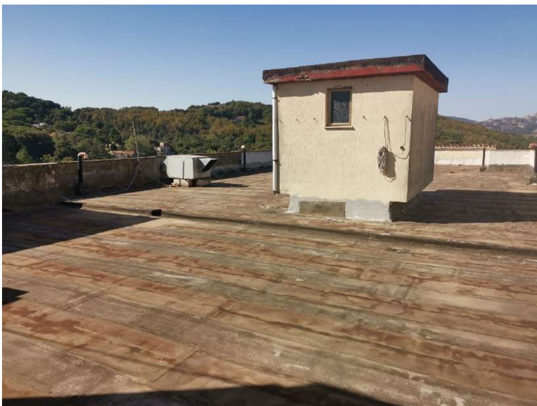
Foto 011 – Dettaglio copertura edificio
