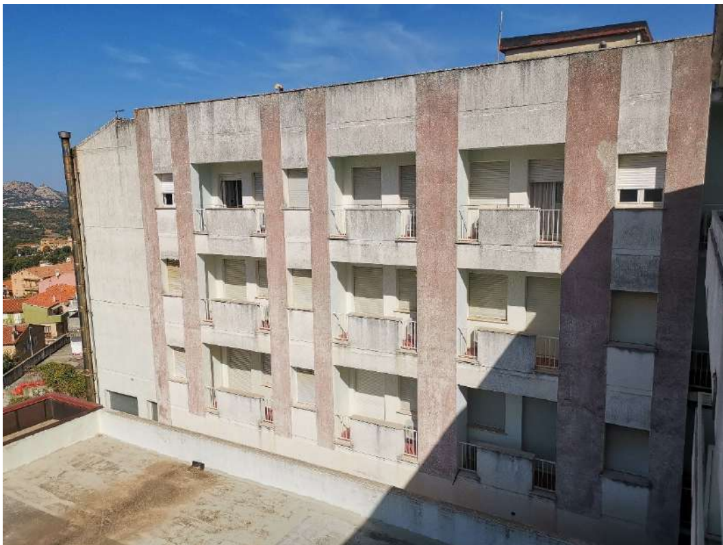
Foto 010 – Dettaglio facciata interna laterale
