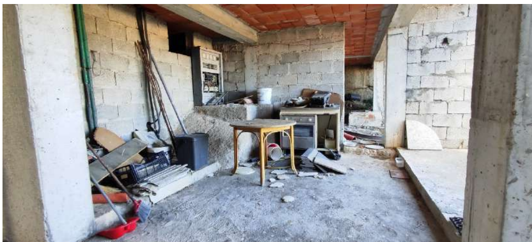
Foto 119 – Dettaglio locale adiacente scale esterne
