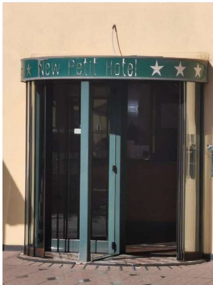
Foto 013 – Dettaglio Ingresso Principale
