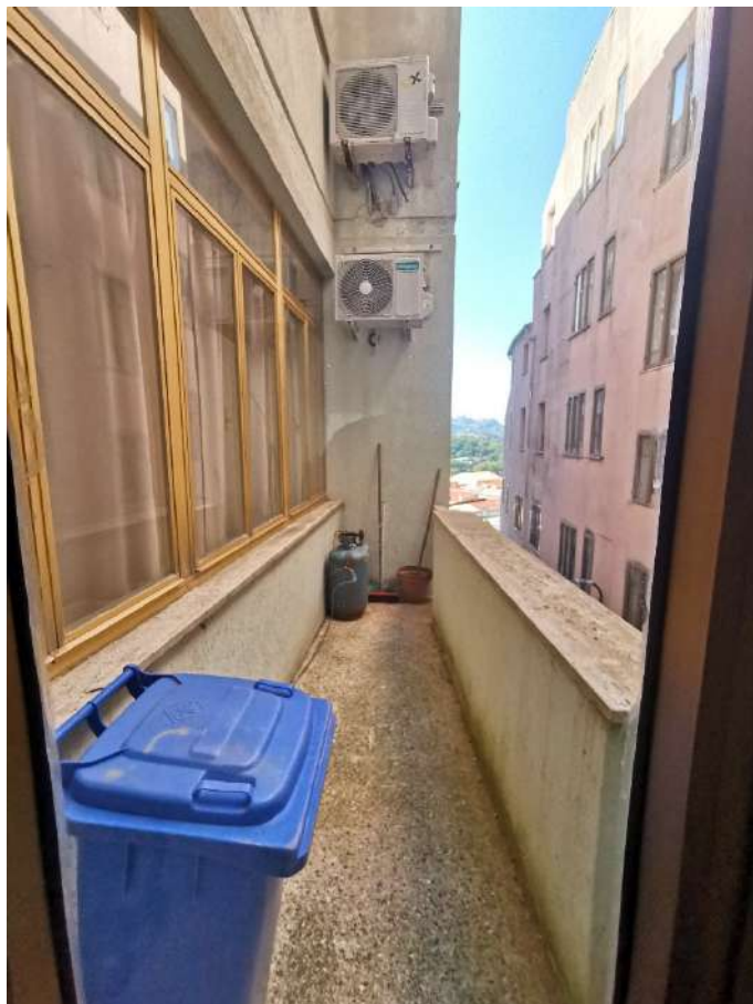
Foto 032 – Terrazzino Appartamento alloggio Gestore Hotel
