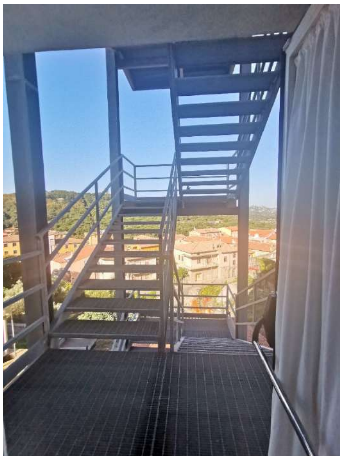
Foto 002 – Dettaglio scale di collegamento esterne
