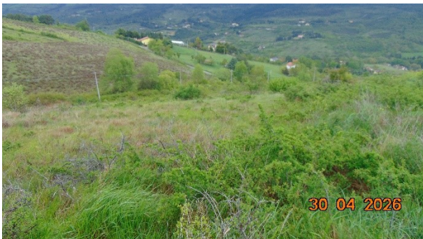
Vista panoramica e linea elettrica
