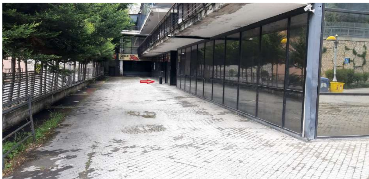
Lotto n. 1 – Ingresso esterno vano scala
