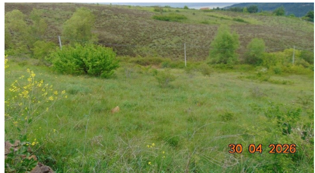
Vista panoramica e linea elettrica
