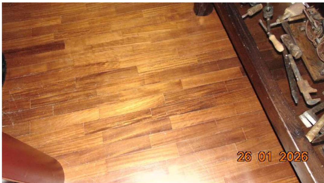
Lotto 1 – Particolare pavimento uffici
