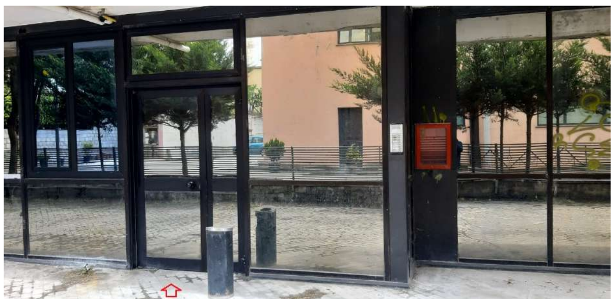
Lotto 1 – Particolare Portone ingresso vano scala
