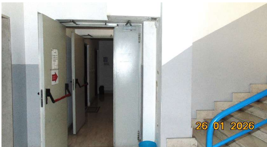
Lotto 1 – Ingresso disimpegno da vano scala
