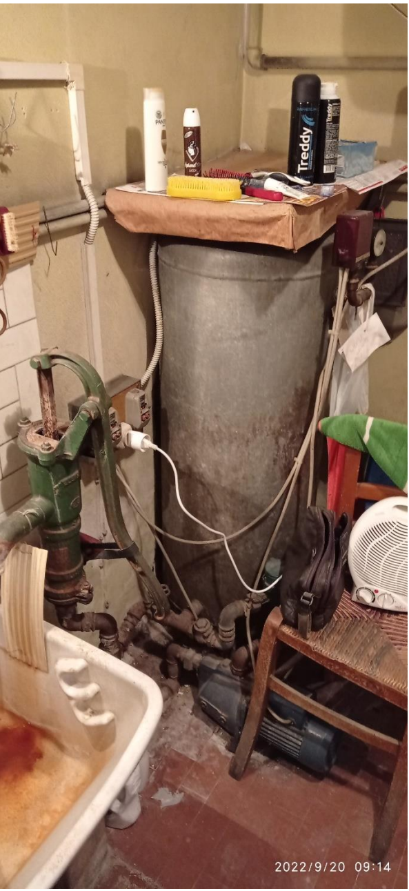
Foto 11: BENE 1: piano terra (locale di servizio)
