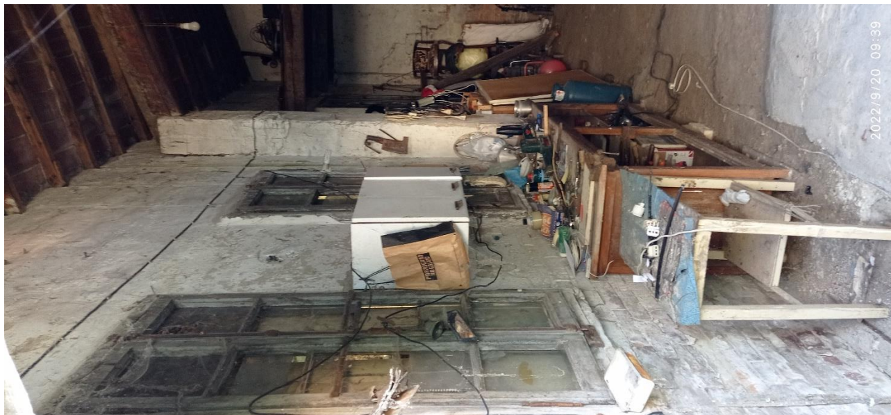
Foto 20: BENE 3 piano terra (rustico)
