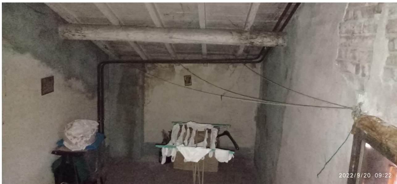
Foto 16: BENE 1: primo piano: sottotetto
