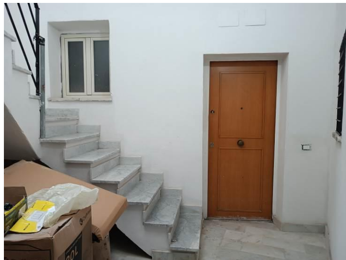
Fig. 10 Chiostрина con scala di accesso al piano 3.
