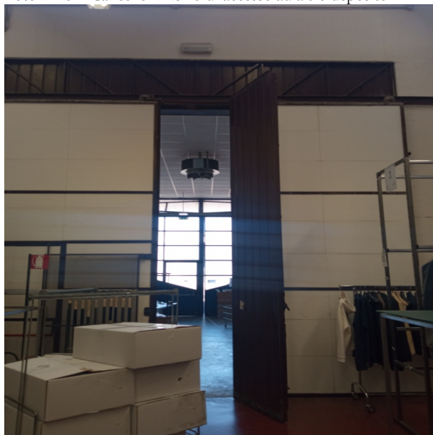
Foto n. 15 – Cannello in ferro di accesso ad altro deposito
