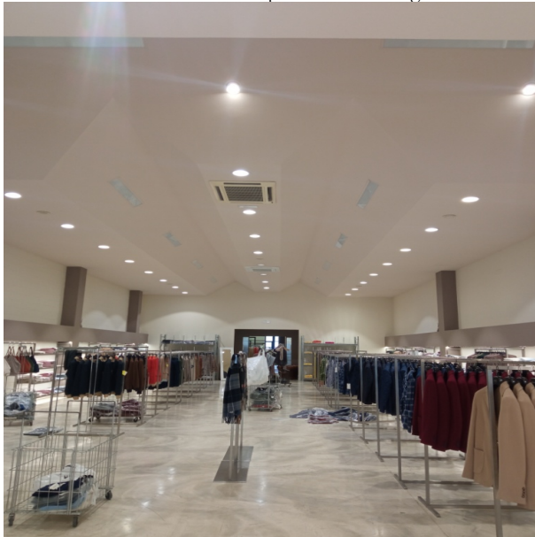
Foto n. 29 – Soffitto dell'area espositiva in cartongesso
