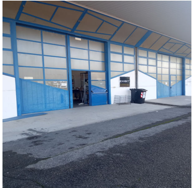
Foto n. 18 – Area esterna carico e scarico merce
