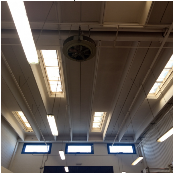
Foto n. 13 – Soffitto del deposito
