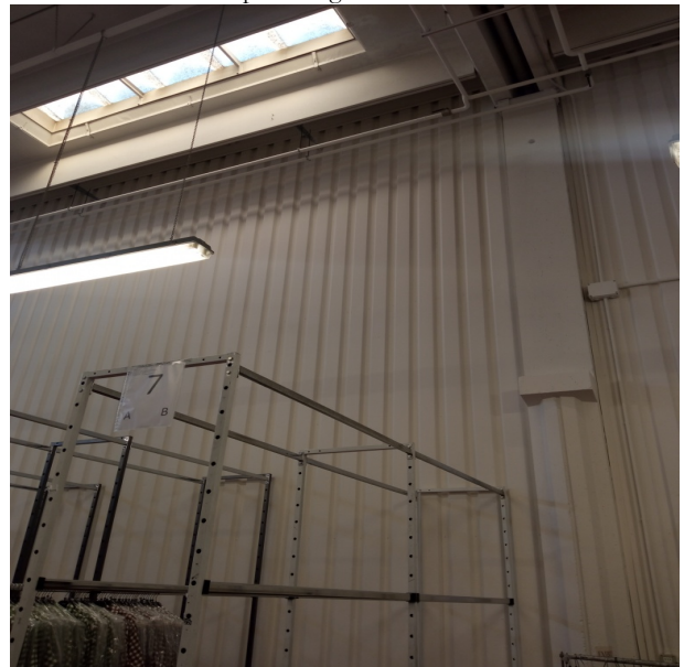
Foto n. 14 – Parete in pannelli grecati
