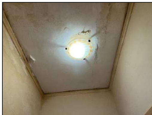
Fotografia 12 – Particolare solaio disimpegno
