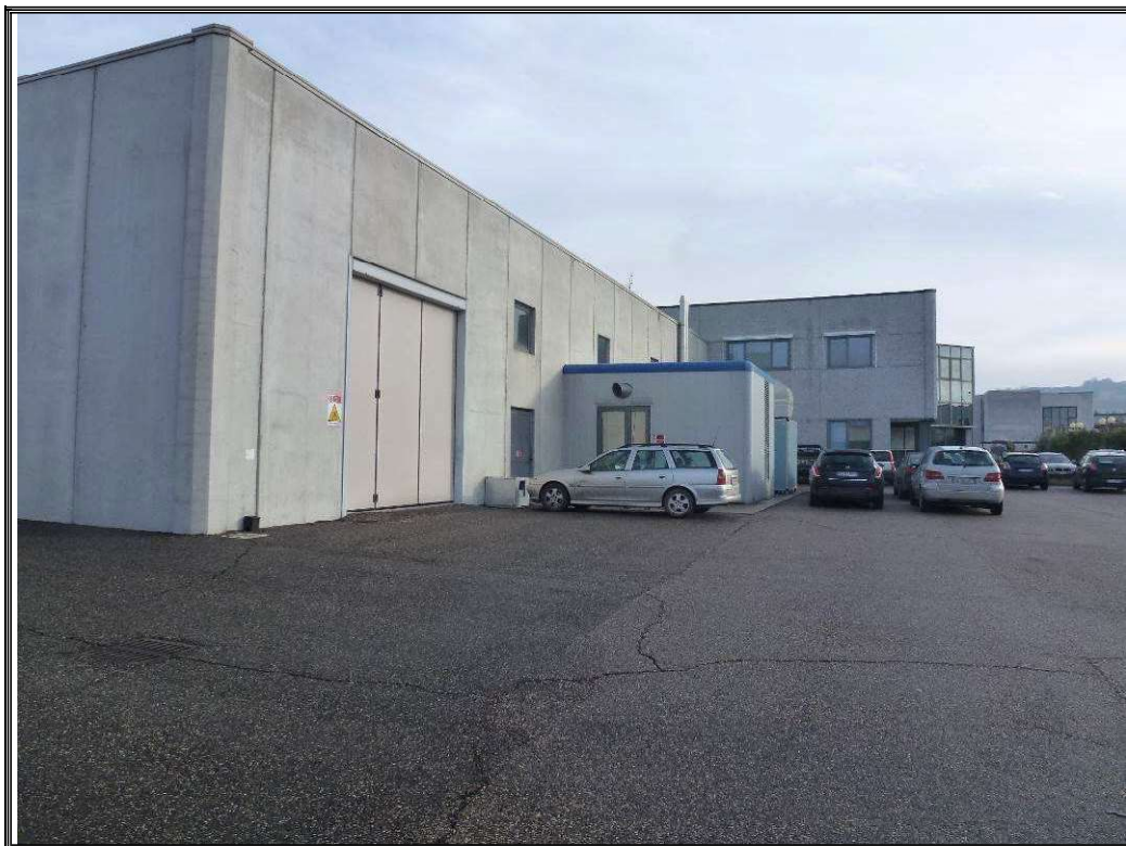
Foto n. 5 Vista esterna dell'immobile e della corte esterna ad uso esclusivo.
