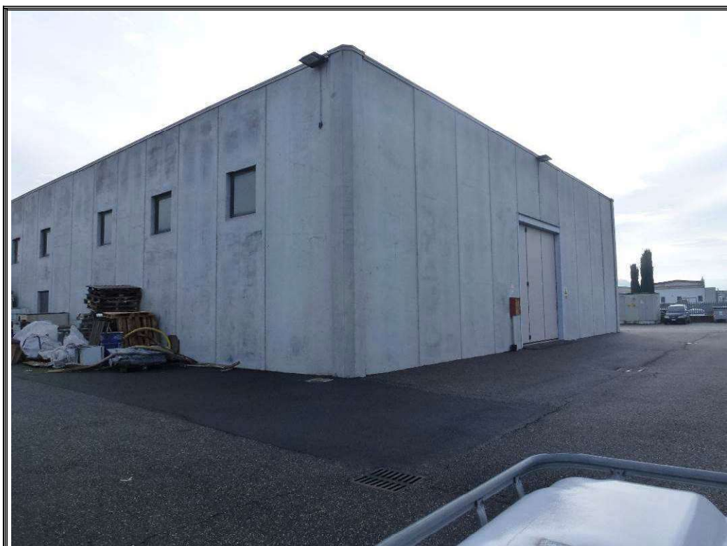
Foto n. 4 Vista esterna dell'immobile e della corte esterna ad uso esclusivo.
