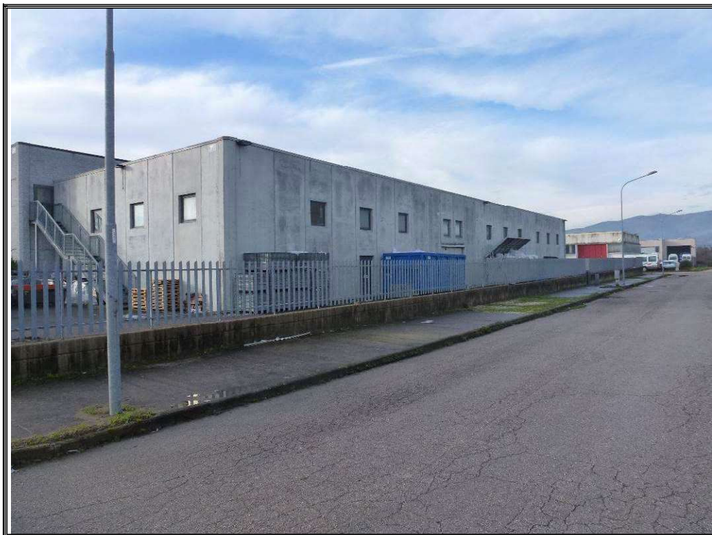
Foto n. 3 Vista esterna dell'immobile.
