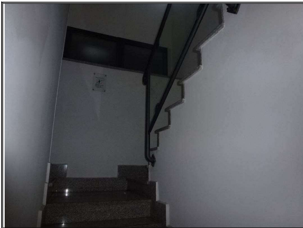
Foto n. 23 Scala di collegamento al piano rialzato lato locale mensa.
