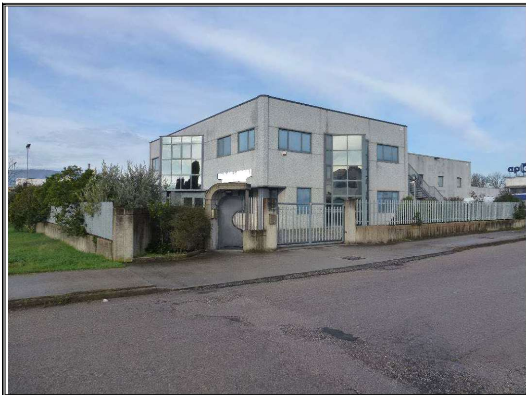
Foto n. 1 Vista esterna dell'immobile lato ingresso principale.
