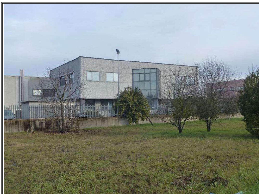
Foto n. 6 Vista esterna dell'immobile.
