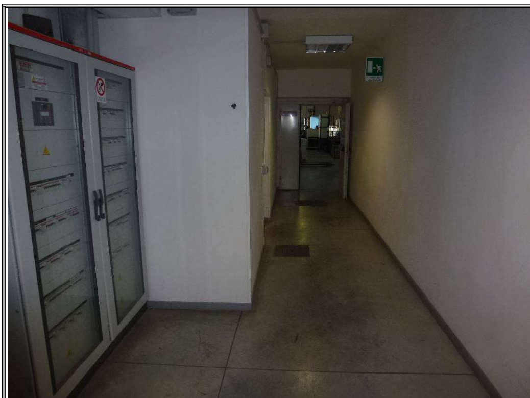
Foto n. 16 Corridoio piano terra.
