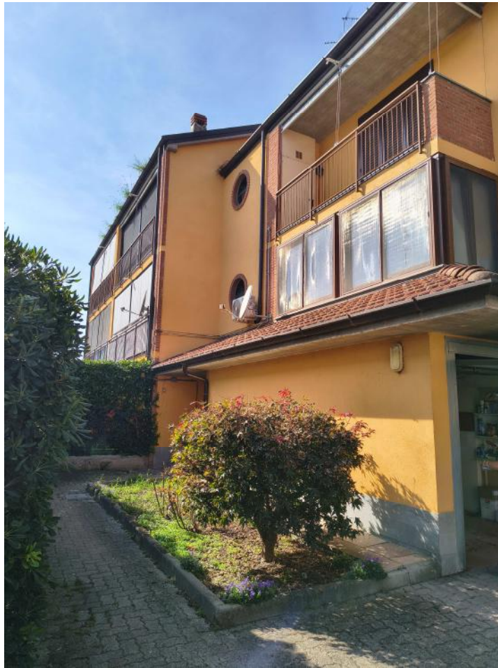
1. Prospetto principale del Condominio Grugnetto 8
