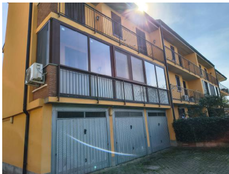
2. Prospetto retrostante del Condominio Grugnetto 8
