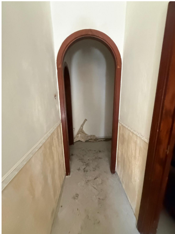
Disimpegno di ingresso
