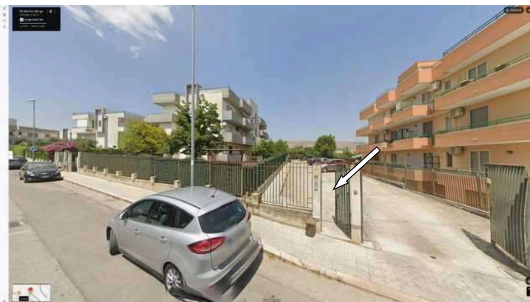
Figura 3: Ul ad uso ufficio (adibita ad abitazione) in Manfredonia (FG) – via Orto Sdanga n.106 (41.636974, 15.911028)
