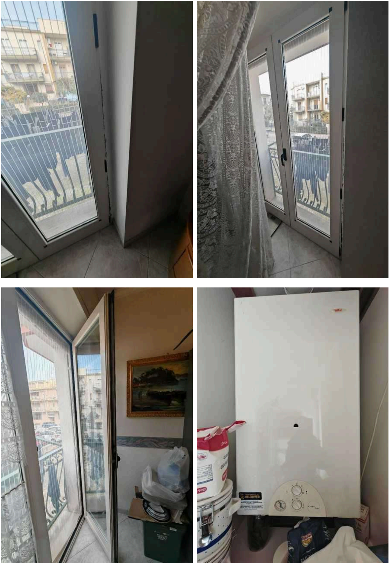
Figura 9: interno unità immobiliare sub.26-27 (cucina/balcone)
