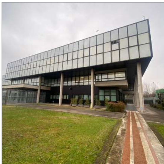
FOTO 5 - L'ingresso da Via Vecchia Ferriera
