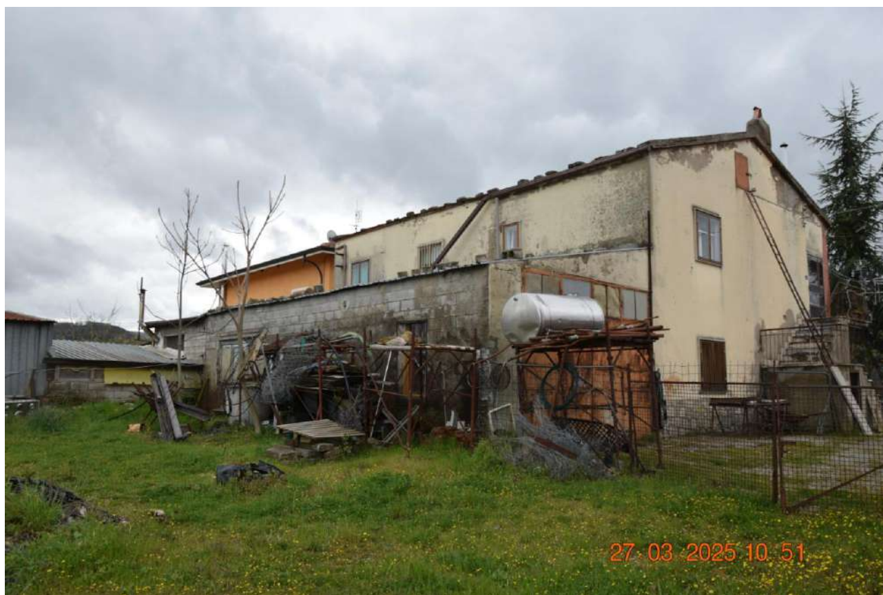
Prospetto Posteriore del fabbricato
