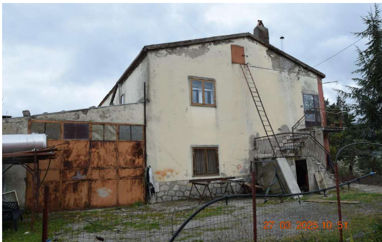
Prospetto laterale del fabbricato
