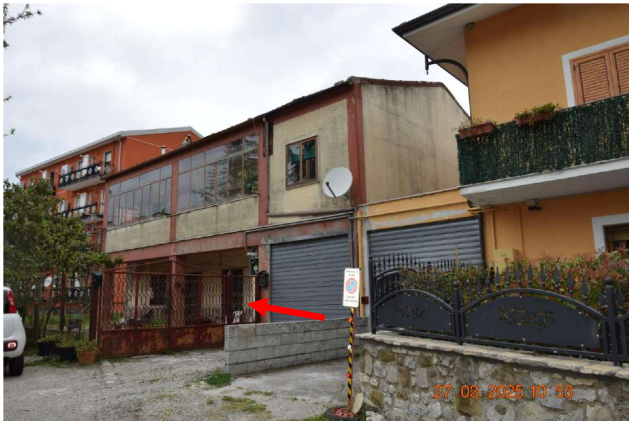
Prospetto di Principale del fabbricato con accesso
