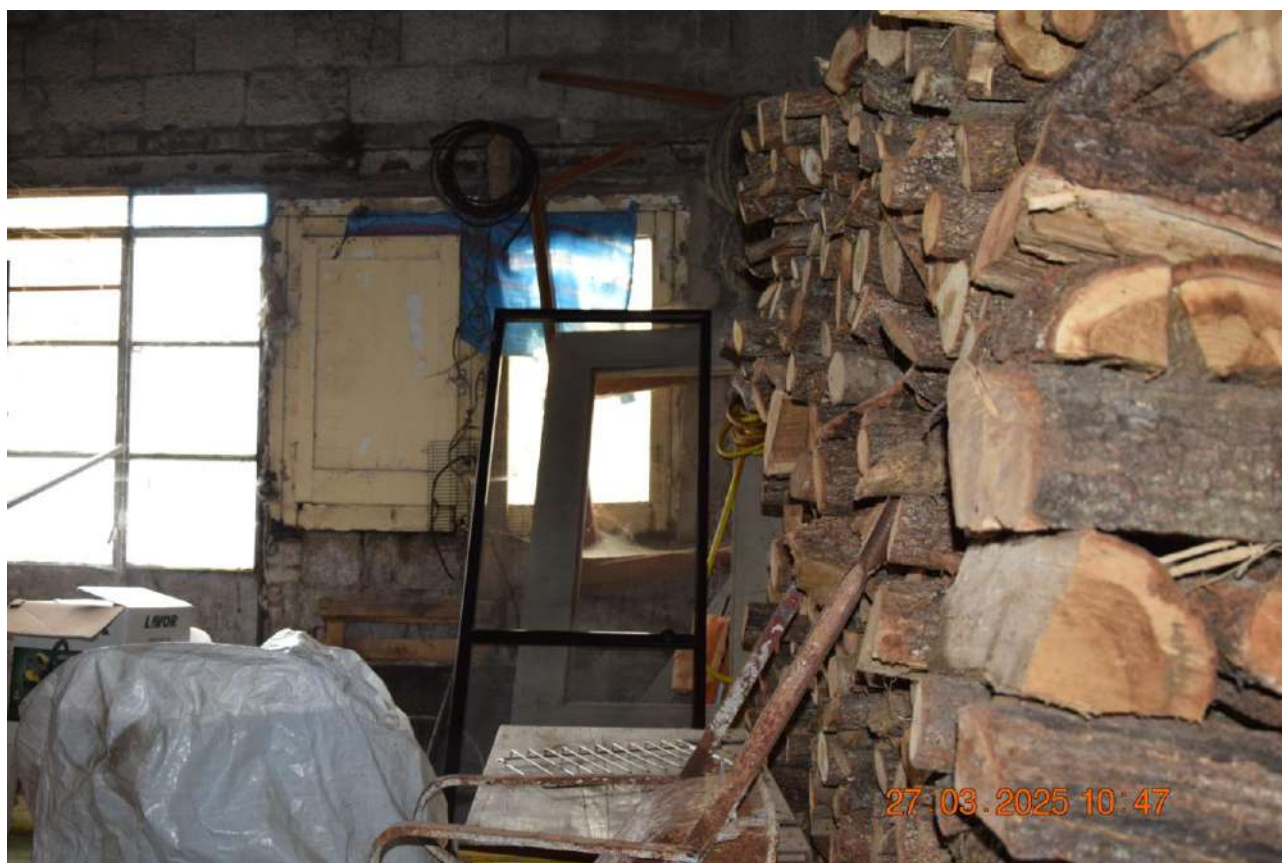
Piano Terra – deposito Parte 2 di 2
