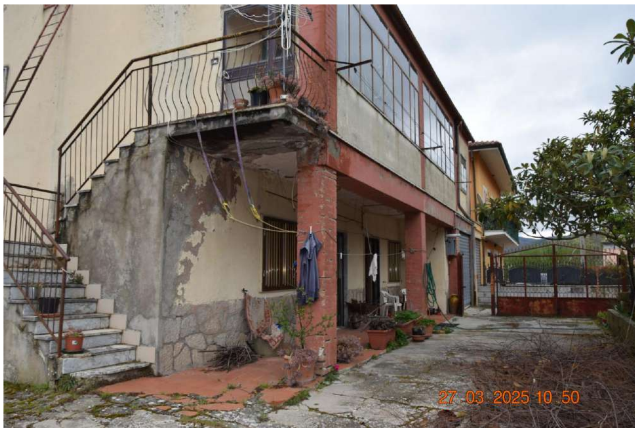
Area esterna con cancello d'ingresso al fabbricato
