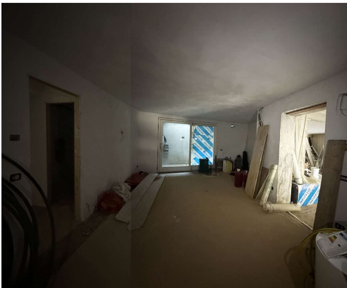
Foto nn. 68-69. Piano S1. Vano ripostiglio
