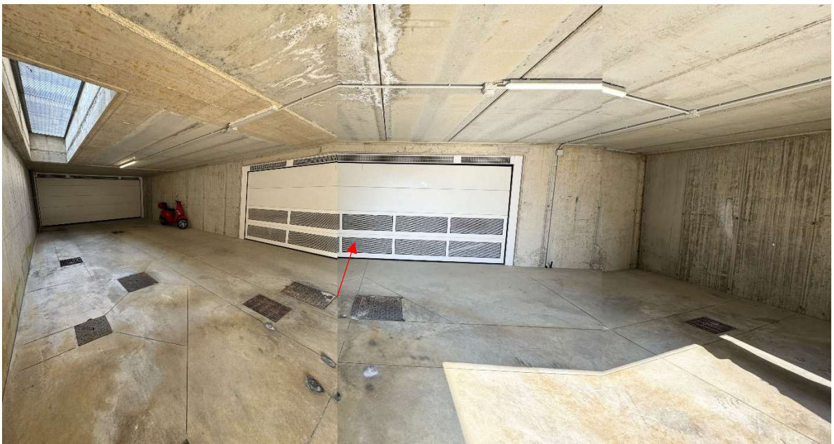
Foto n. 77. Piano S1. Box auto
