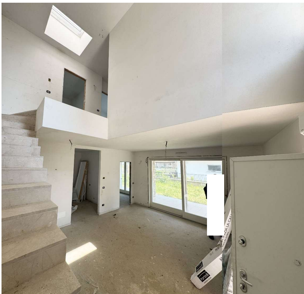
Foto nn. 20-21-22. Piano Terra. Scala di collegamento al piano primo, ingresso abitazione e soggiorno
