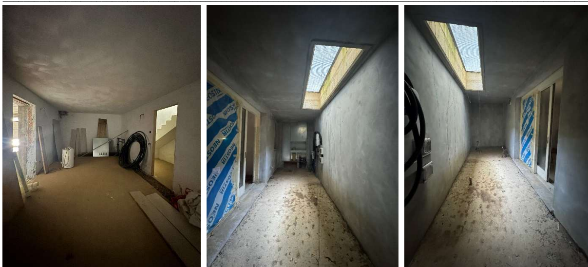
Foto nn. 70-71-72. Piano S1. Vano ripostiglio e intercapedine
