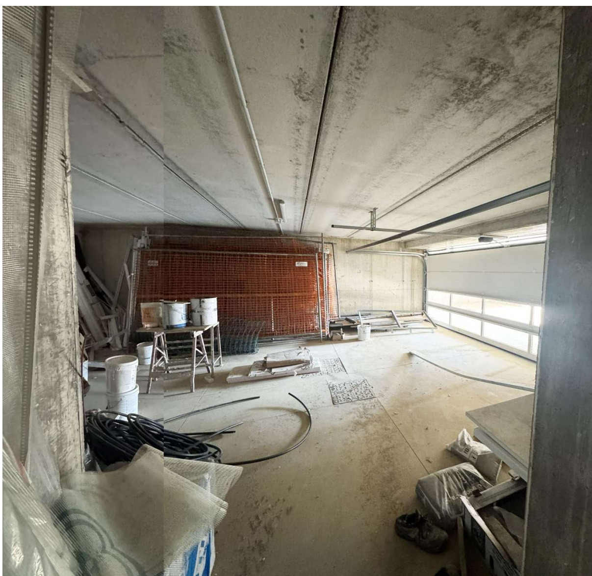
Foto n. 73. Piano S1. Box auto
