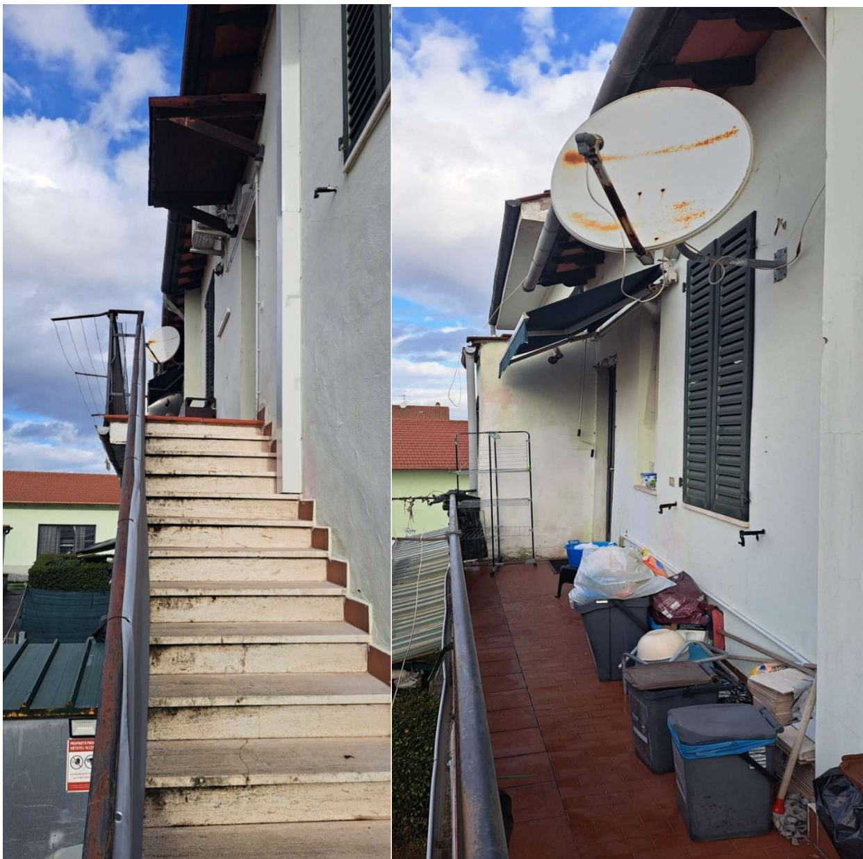
Foto 3 e 4 VISTA rampa scala + ballatoio a comune
