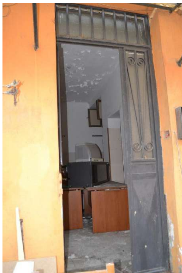
Fotografia n. 2 – Portone di ingresso immobile
