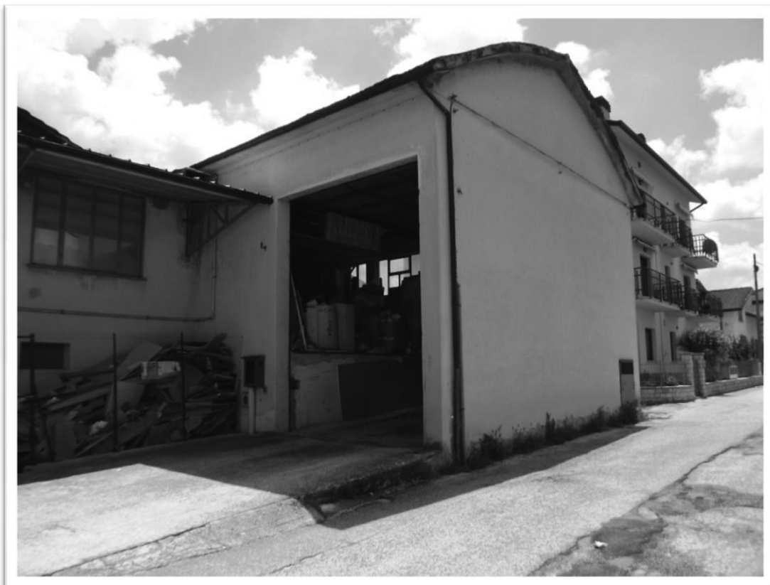
Foto 19 – Lotto B, magazzino, accesso esterno da Via Trento Alimenti
