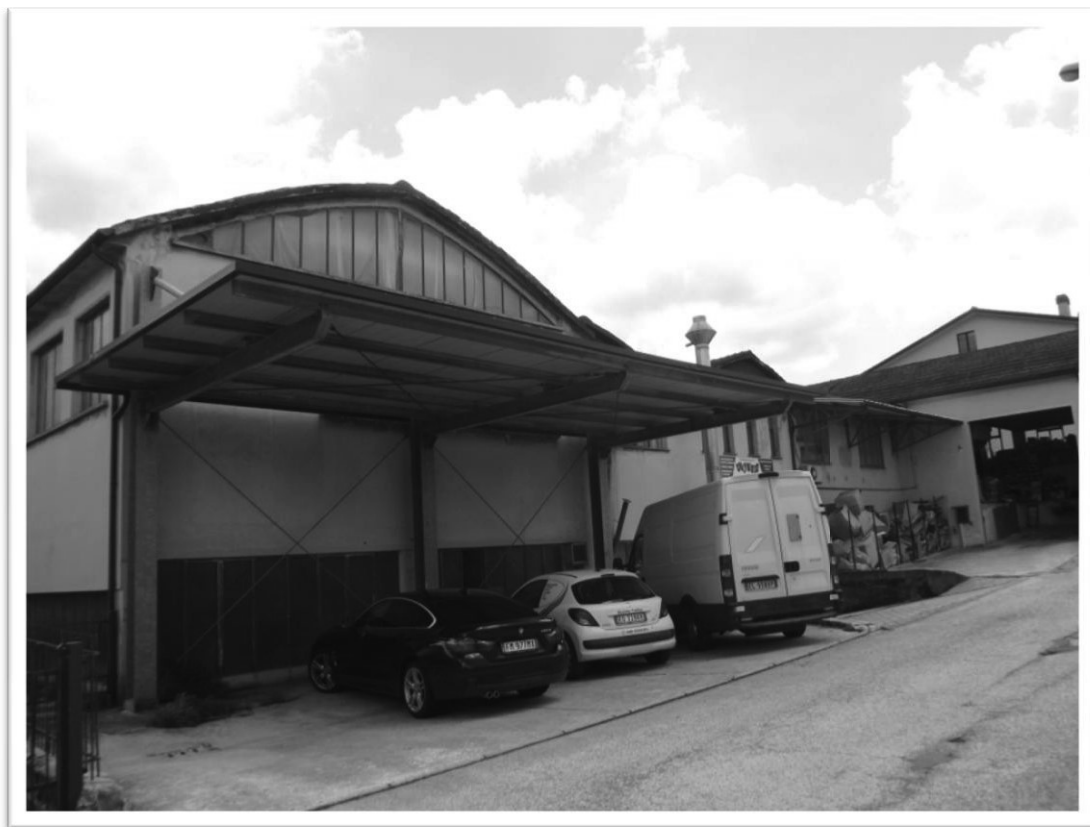
Foto 4 – esterno edificio, prospetto OVEST
