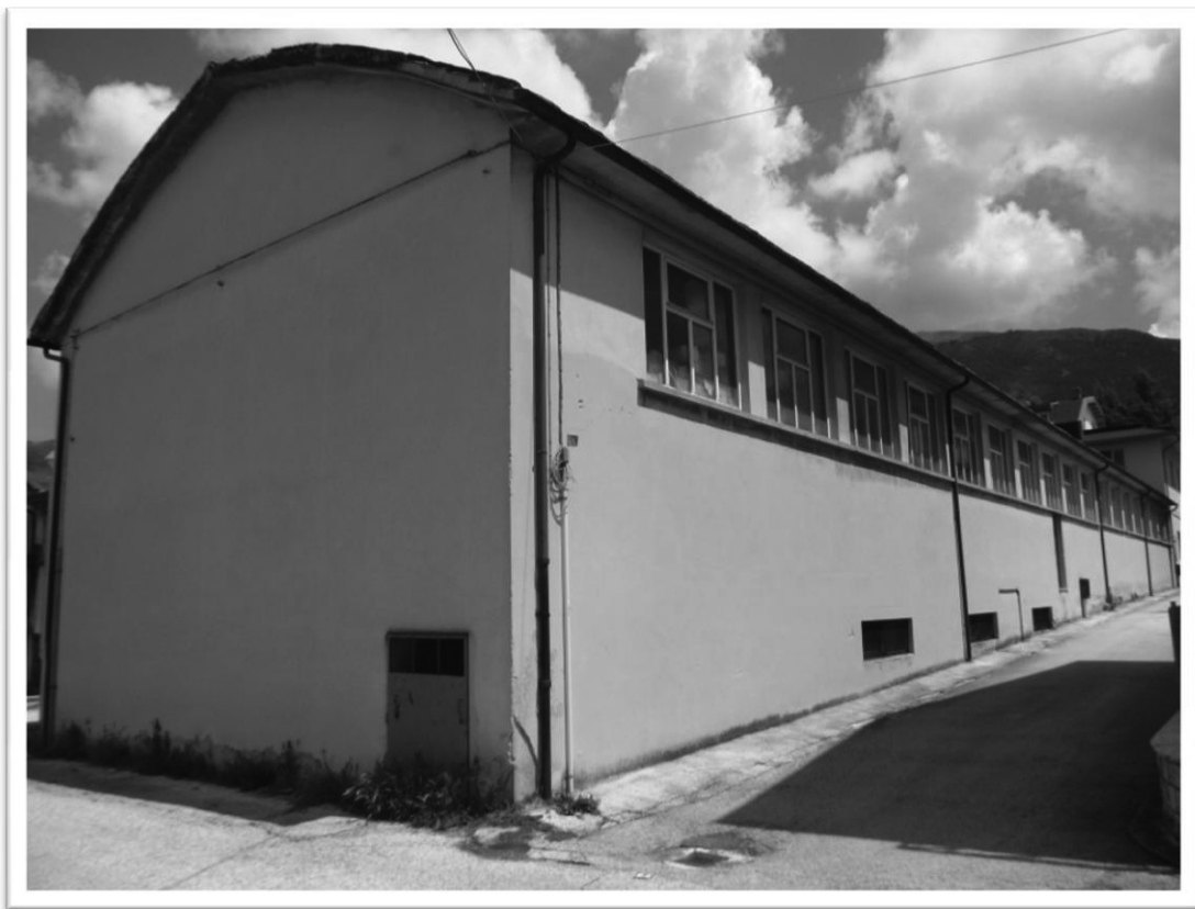
Foto 3 – esterno edificio, prospetto SUD
