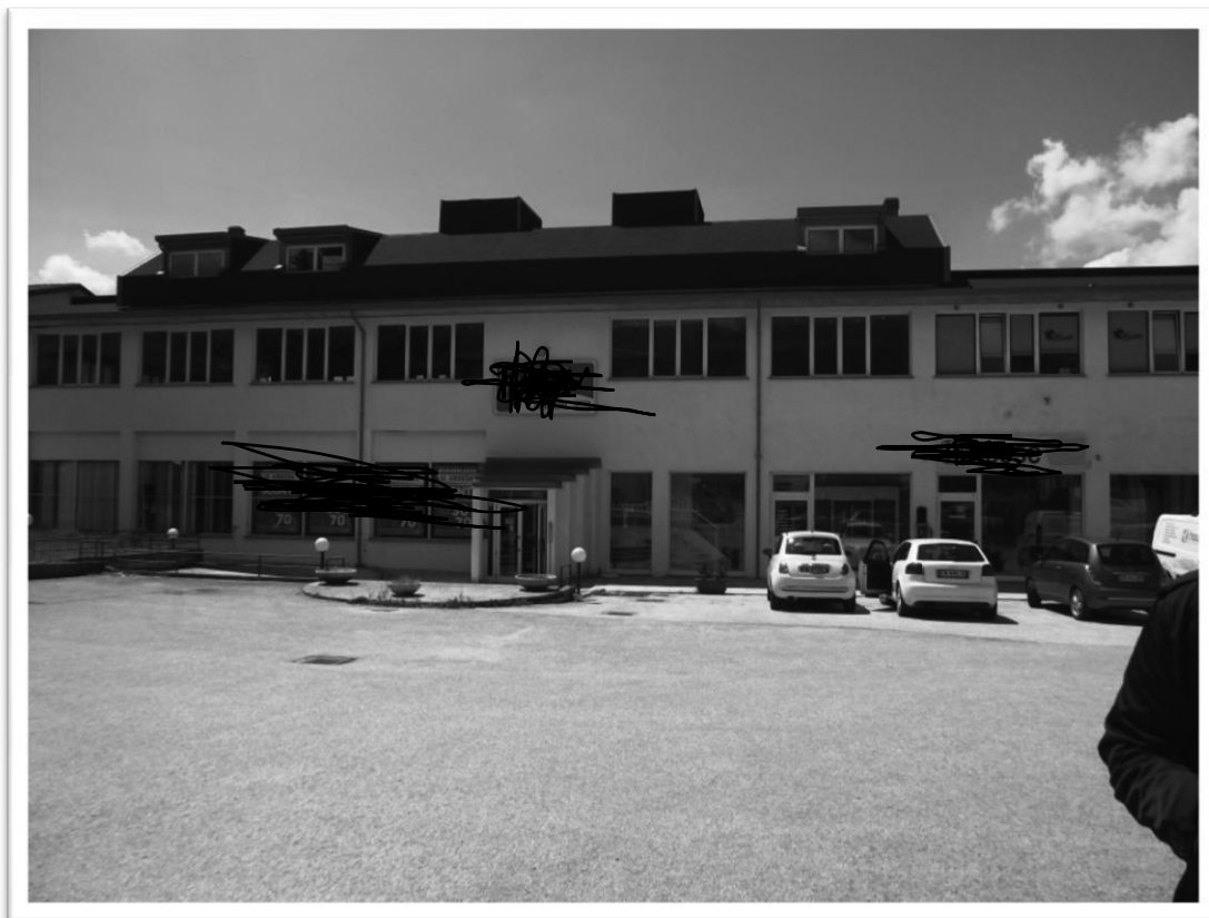
Foto 1 – esterno edificio, prospetto EST
