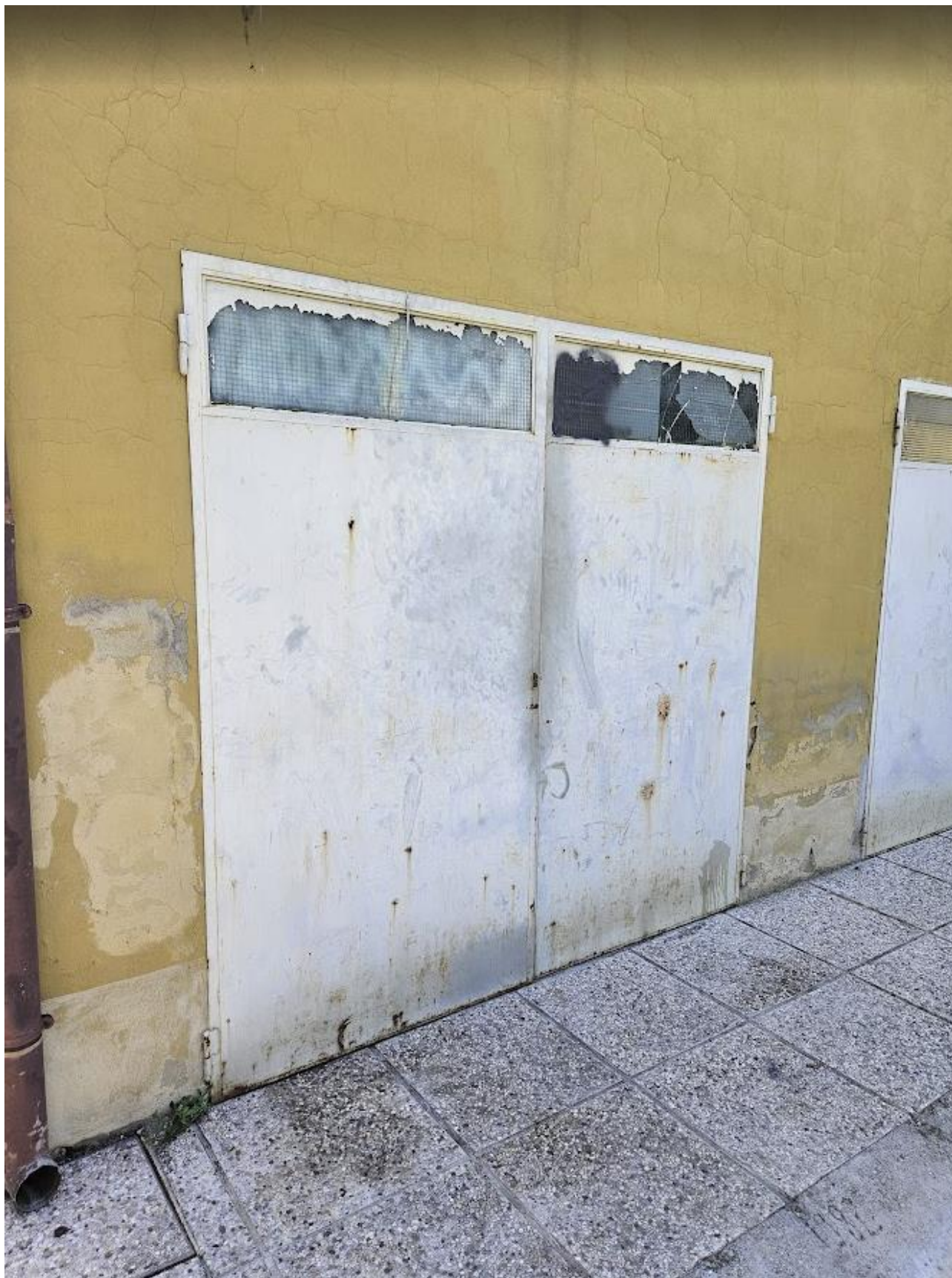
Autorimessa Vista esterna
