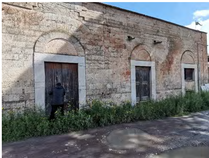
Il fabbricato non abitabile p.lla 51
