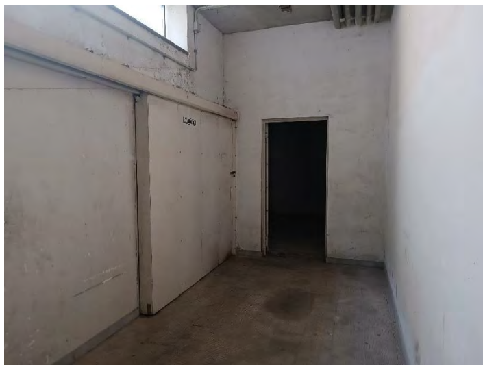
La cantinola sub 139
