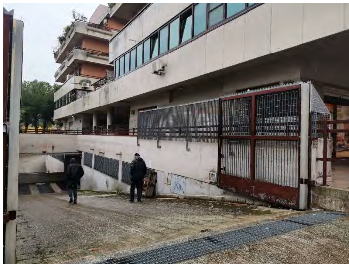
Rampa d'accesso al lotto 9
