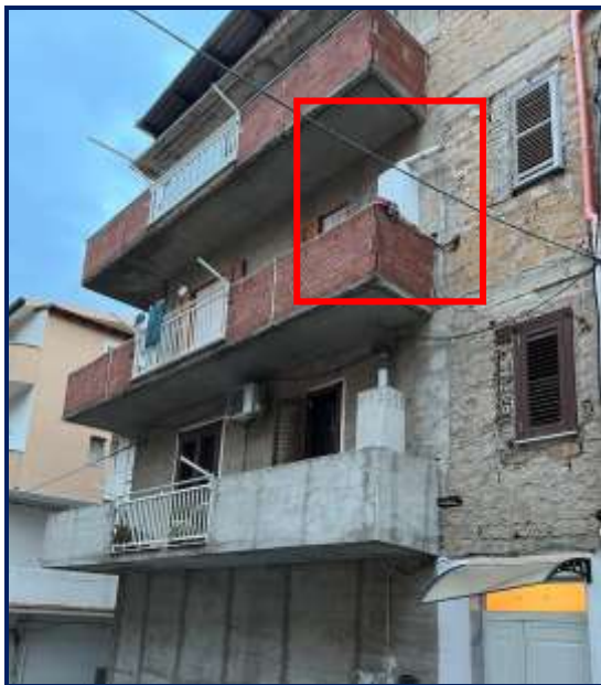
foto n° 15 (caldaia a gas-metano)
