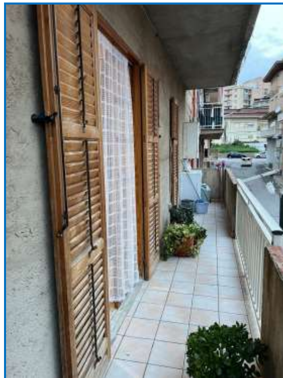
Foto n° 12 Ballatoio lato Via M.T Cicerone
