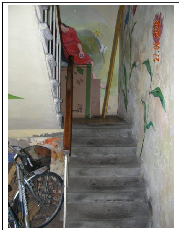
Foto 5) Scala comune di accesso
