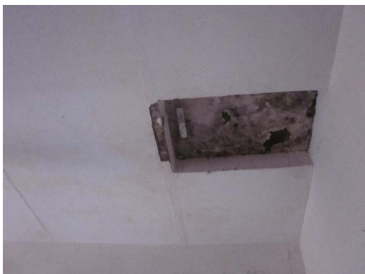
Foto 6. Ingresso: la botola per il sottotetto.
