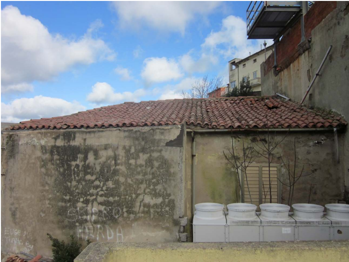
Foto 3. Facciata sul retro, verso il cortiletto.
