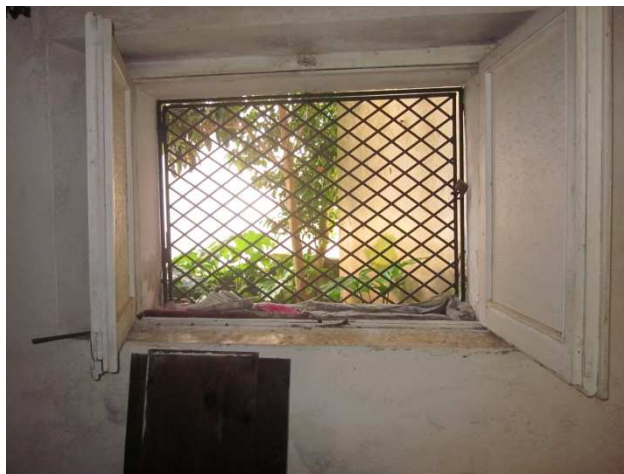
Foto 19. Interno: seminterrato: la finestra con la grata, unico punto d'accesso per la seconda corte.
