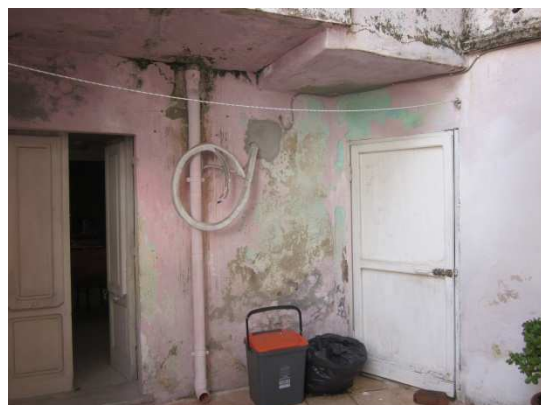
Foto 5. Esterno: seminterrato: entrata e ripostiglio.
