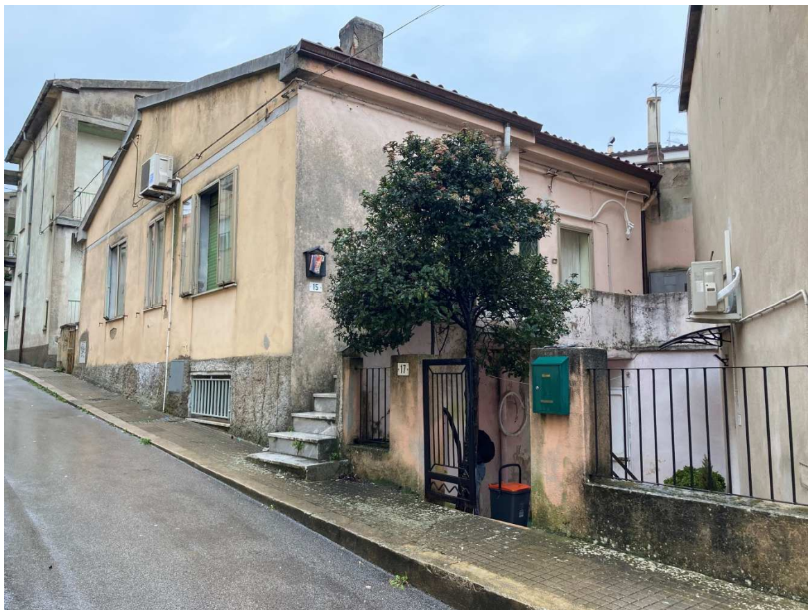
Foto 1. Esterno: la facciata principale. L'unità immobiliare è al primo terra e seminterrato, civici 15 e 17.
