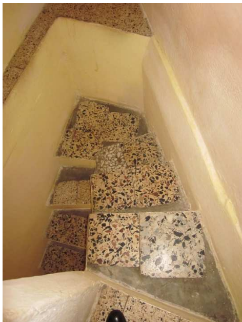
Foto 14. Interno: la scala di collegamento tra i due piani.
