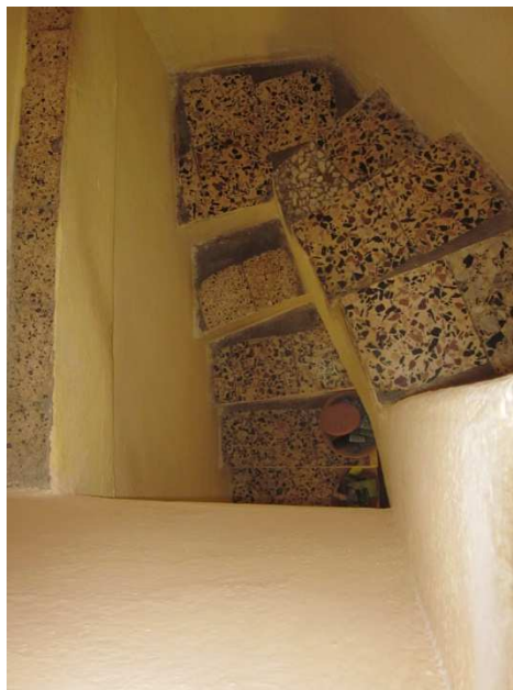
Foto 15. Interno: altra vista della scala interna.
