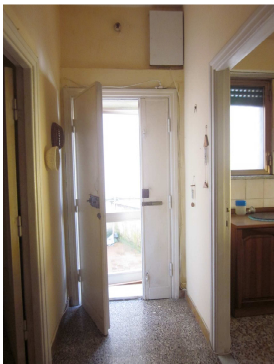
Foto 12. Interno: piano terra: l'ingresso.
