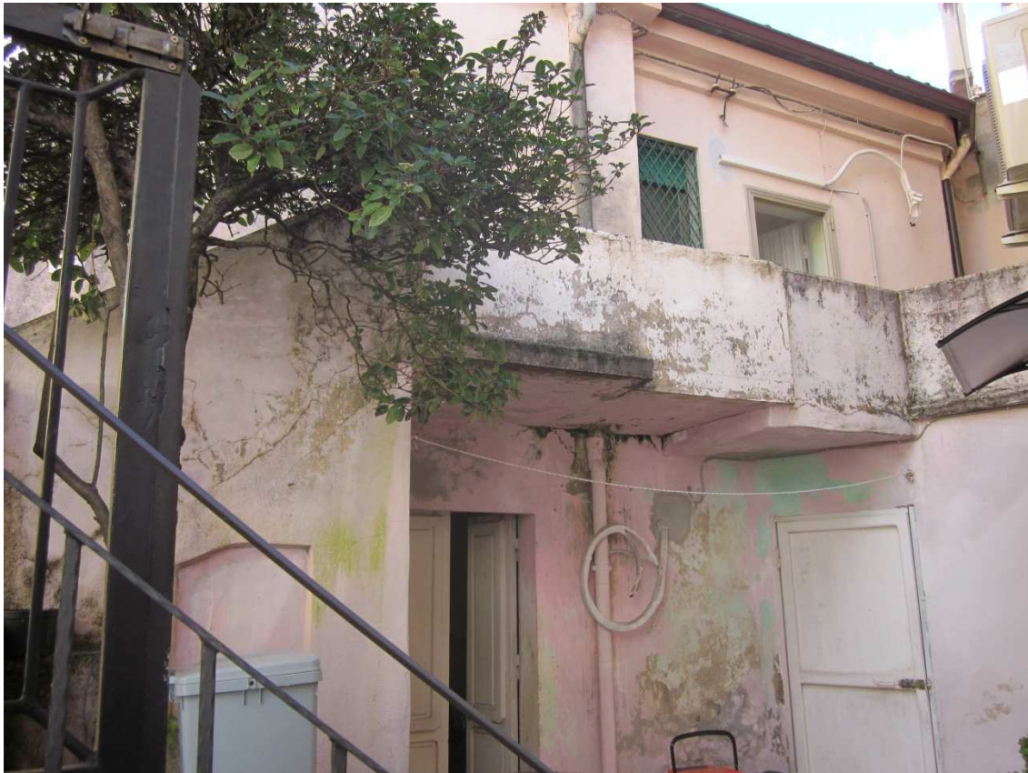
Foto 3. Esterno: la facciata sulla corte.
