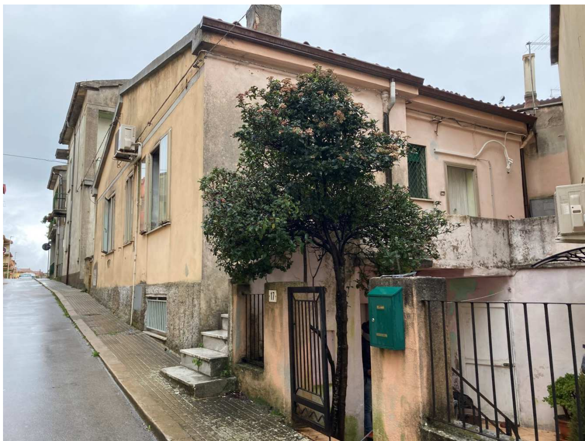
Foto 2. Esterno: la facciata sulla via e sulla corte. In basso si nota la porta del ripostiglio.
