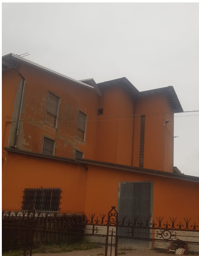
Figura 3 FIANCO VERSO STRADA
