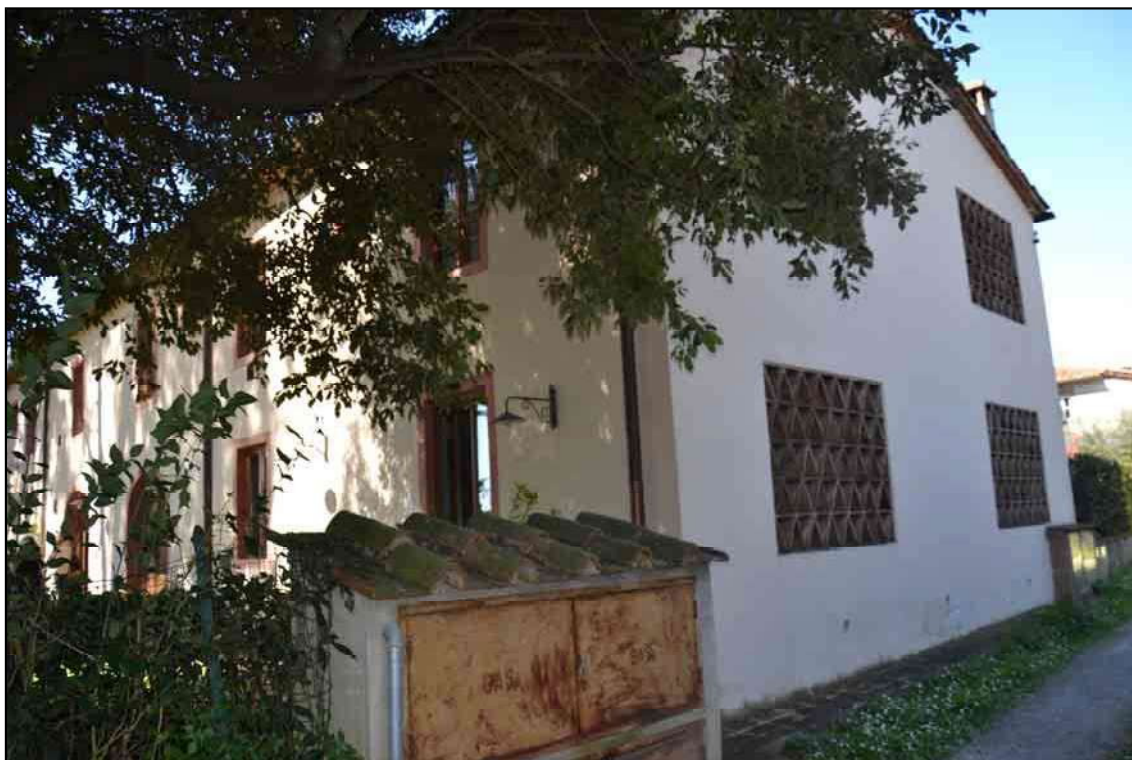
Fotografia n. 3 Fronte laterale del fabbricato
