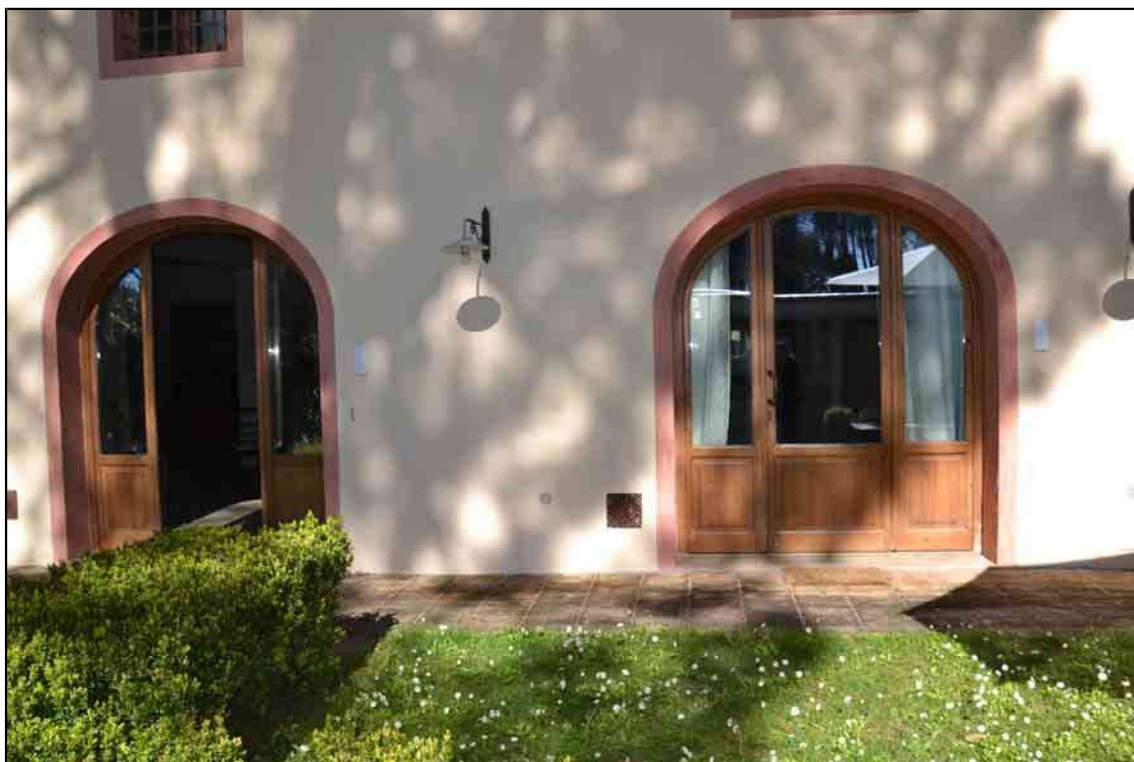
Fotografia n. 17 Ingresso all'Unità B
