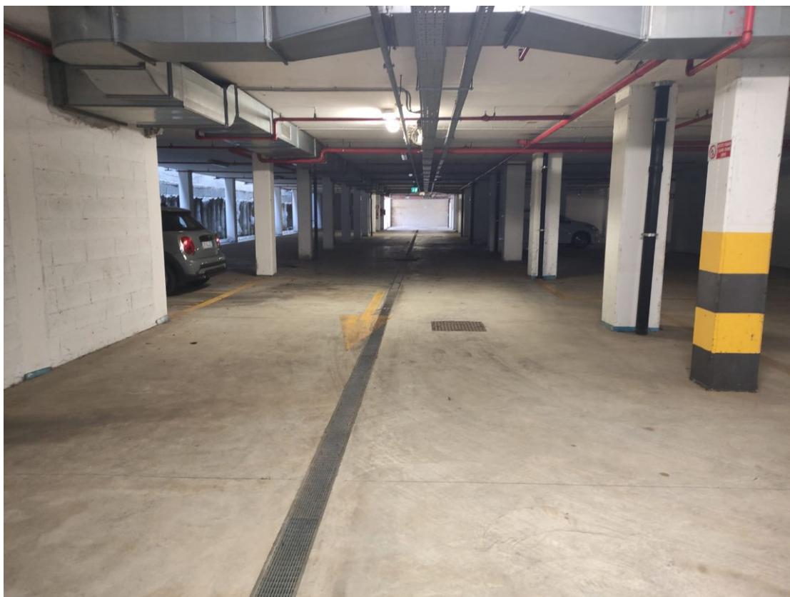
CORSIA DI MANOVRA
