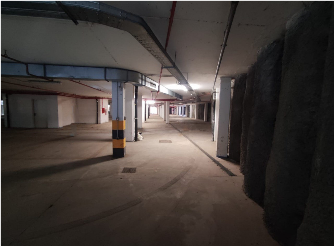
CORSIA DI MANOVRA
