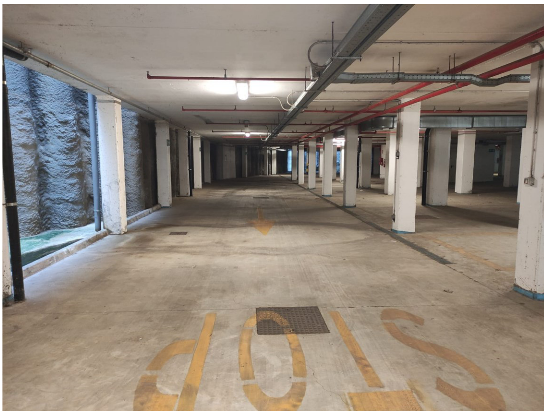
CORSIA DI MANOVRA
