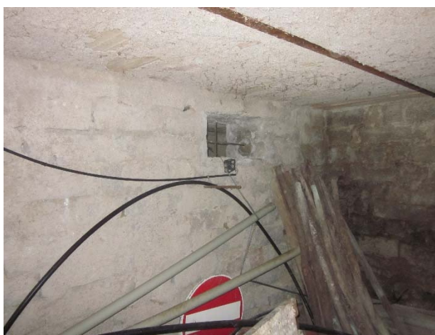
Foto 20. Il magazzino del seminterrato, parte "vecchia".
