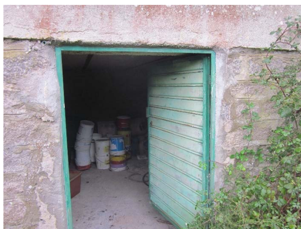
Foto 19. Il magazzino del seminterrato, parte "vecchia".
