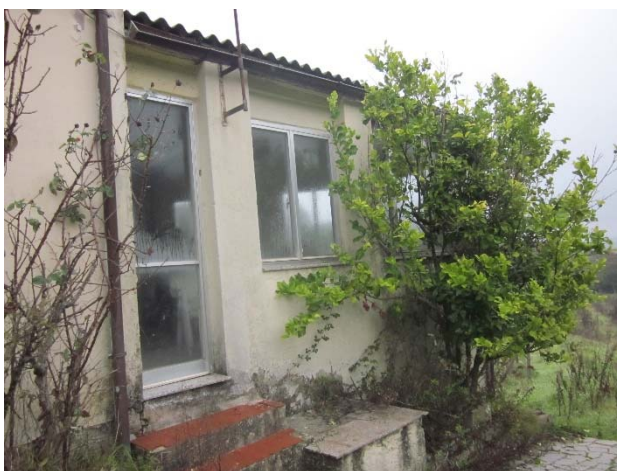
Foto 25. La facciata, lato non autorizzato.
