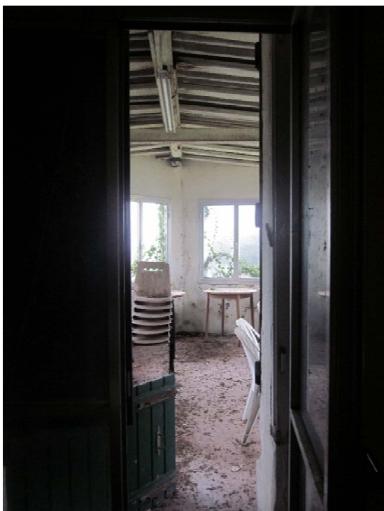
Foto 32. Vista della veranda chiusa dalla camera.
