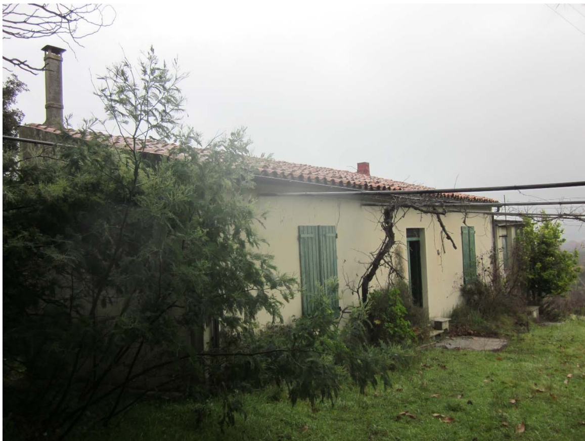
Foto 5. Facciata della casa rurale utilizzata come magazzino.
