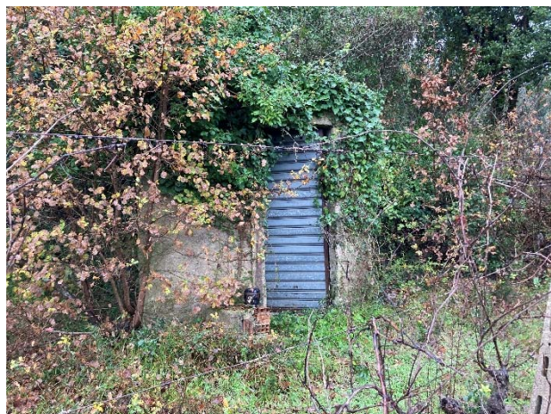
Foto 17. Il locale pompe sommerse nei pressi del confine nord.
