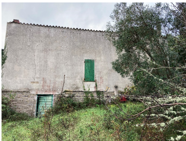
Foto 16. Il fabbricato; facciata nord.
