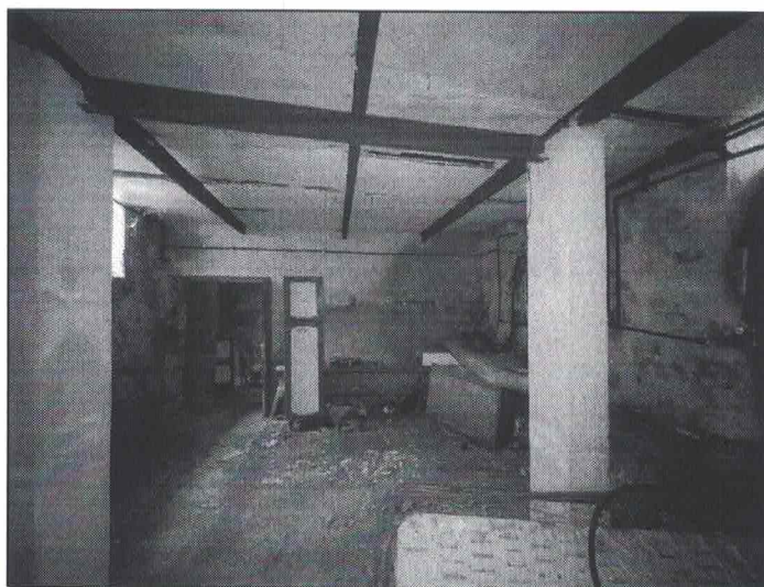
-Cantina al piano interrato-
