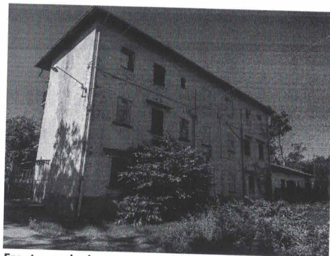
Fronte nord ed est
