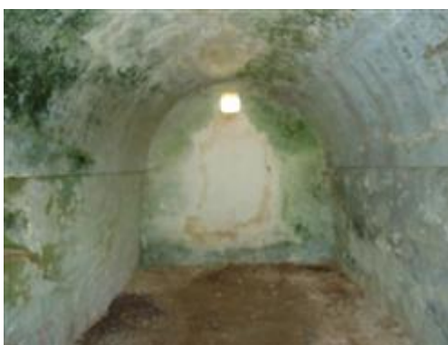
Foto n. 4 interna dell'intradosso della copertura a botte e delle pareti interne
