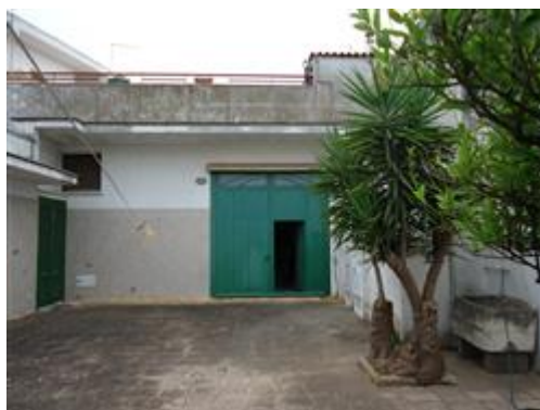
prospetto posteriore prospiciente il cortile retrostante
