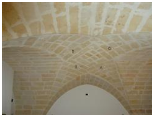
particolare dell'intradosso della copertura a volte
