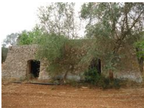
Foto n.3 esterna del fabbricato
