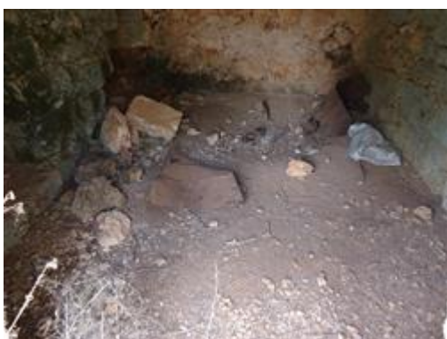
Foto n. 3 della pavimentazione interna
