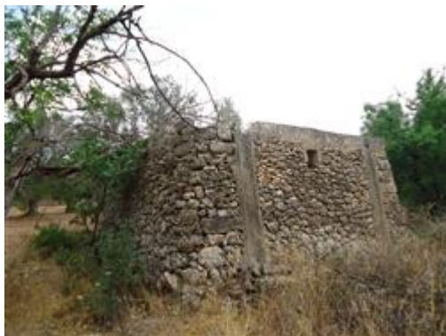
Foto n.1 esterna del fabbricato
