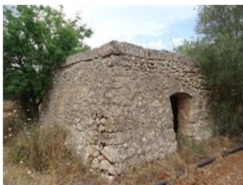
Foto n.5 esterna del fabbricato
