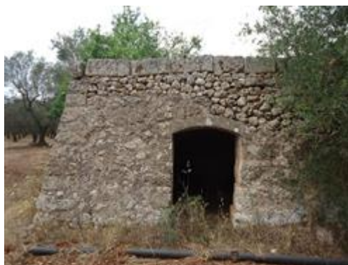
Foto n.4 esterna del fabbricato
