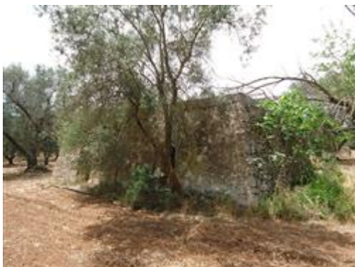
Foto n.5 dell'appezzamento di terreno e del fabbricato collabente
