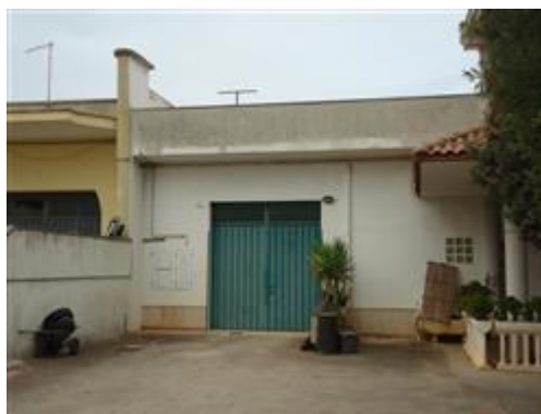
locale magazzino adiacente
