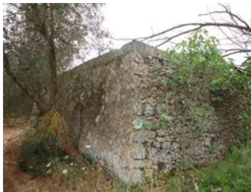
Foto n.2 esterna del fabbricato
