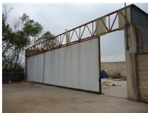
Foto n.2 esterna del portone ad ante scorrevole di accesso
