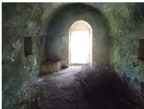
Foto n. 5 delle pareti interne
