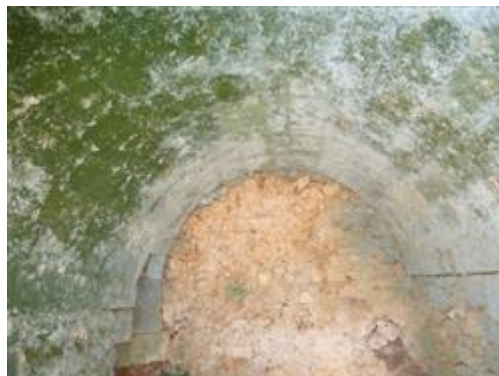
Foto n. 2 interna dell'intradosso della copertura a botte
