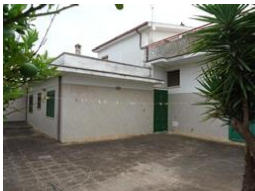
prospetto posteriore prospiciente il cortile retrostante
