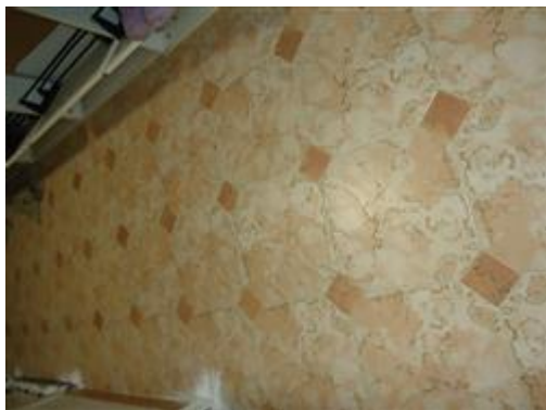
pavimentazione vani retrostanti
