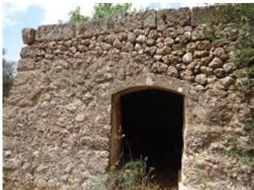
Foto n.1 esterna della muratura
