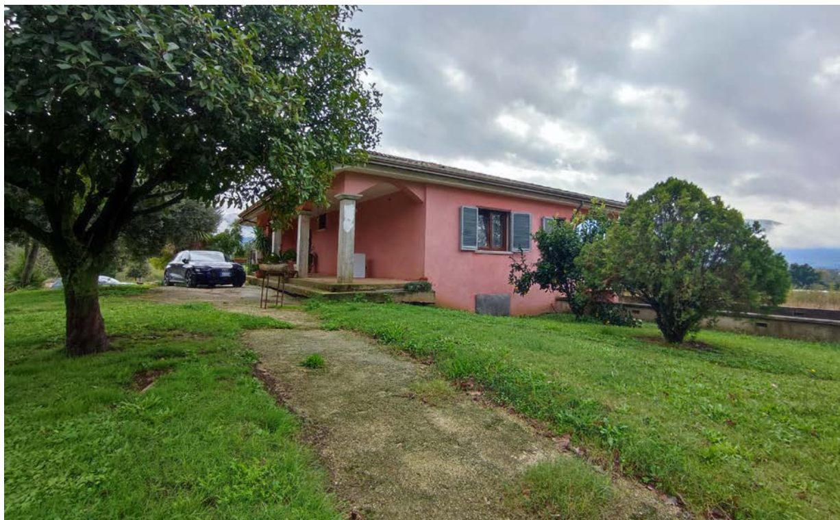
Foto 02. Vista dell'immobile fronte nord est e nord ovest
