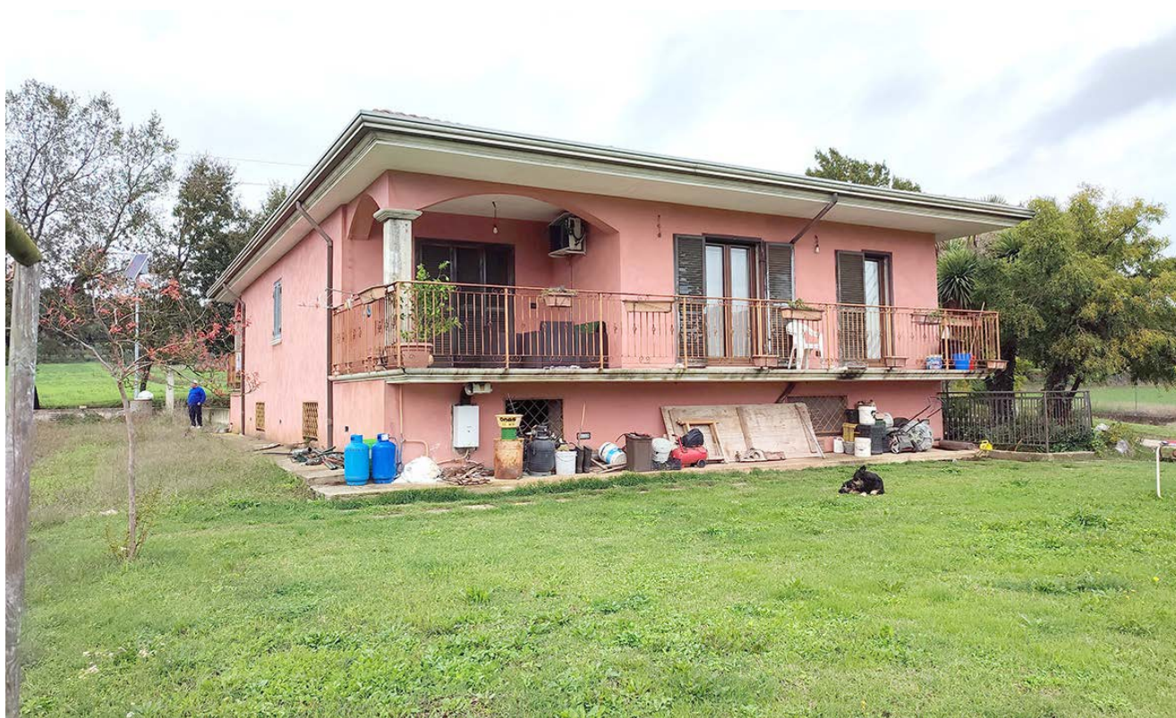
Foto 05. Cespite visto dalla P.Ila 5070 (fronte sud est e sud ovest)
