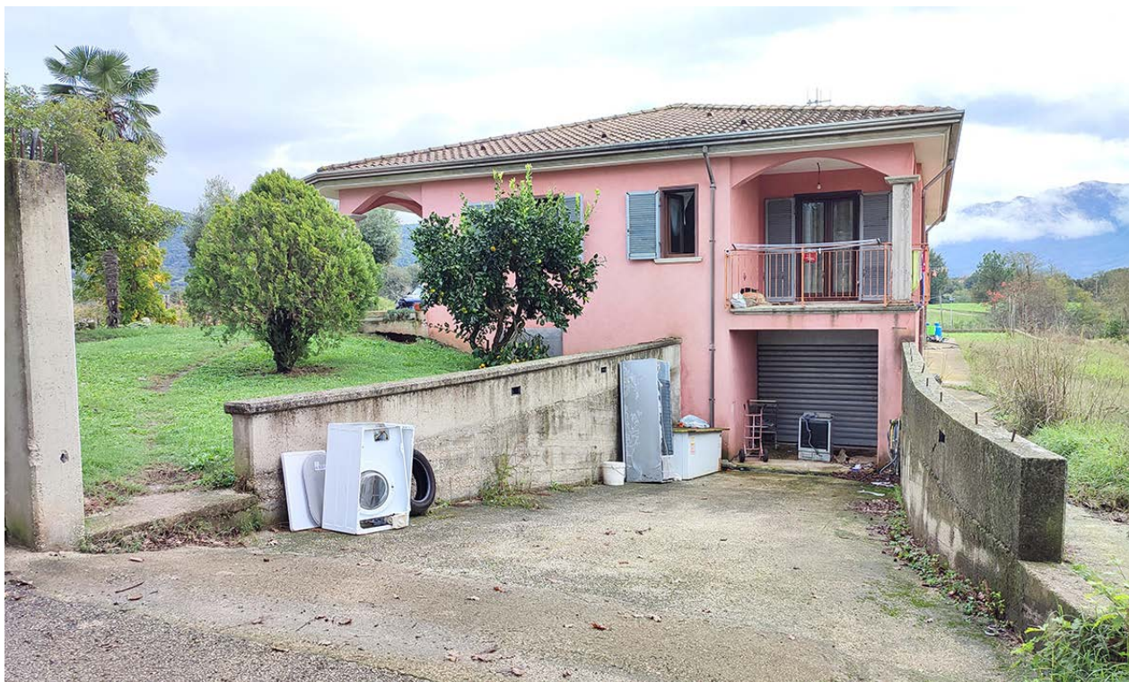
Foto 04. Ingresso carrabile ed accesso al piano seminterrato dalla strada sterrata (nord ovest)
