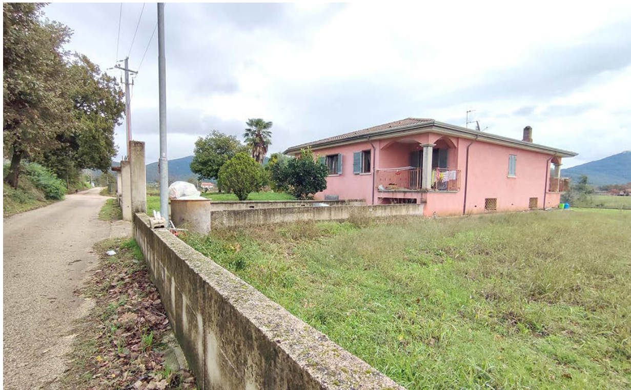
Foto 03. Vista da strada di accesso proveniente dalla SP68 (fronte nord ovest)
