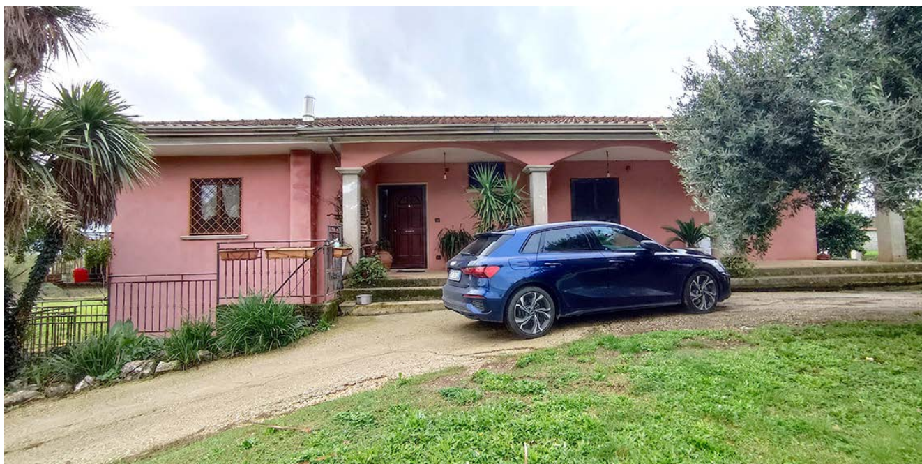
Foto 01. Vista dell'immobile fronte nord est
