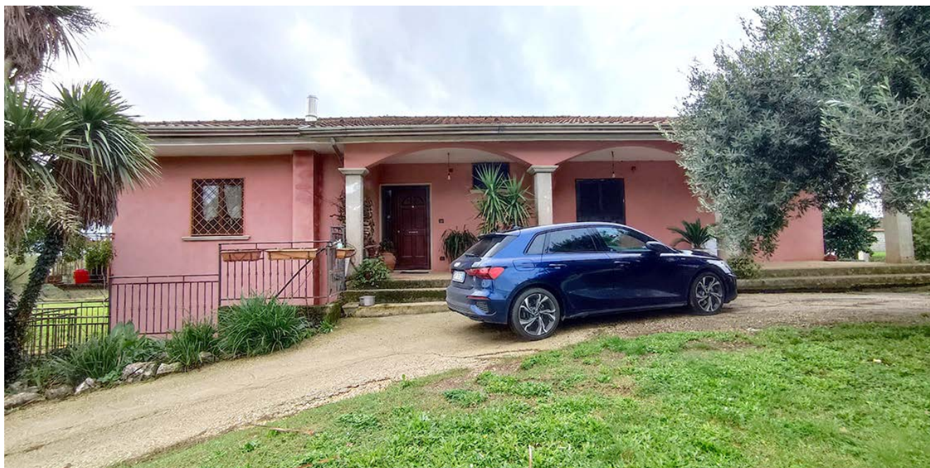
Foto 01. Vista dell'immobile fronte nord est
